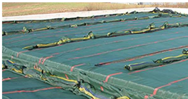
Figura 19. Exemple de coberta de malla amb combinació del sistema de sacs de sorra. (Font: Pinsos Moratos, 2019)
