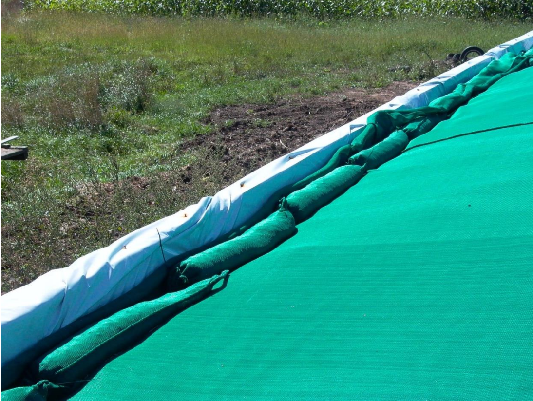
Figura 17. Exemple de sacs de sorra usats en les cantonades dels ensitjats de trinxera. (Font: Hanson Silo Company, 2019)
