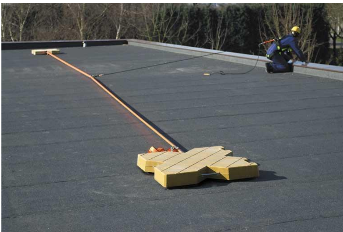
Fig. 7: Sistema de subjecció amb sistema de pesos. (Tectonica online, s.d.)
