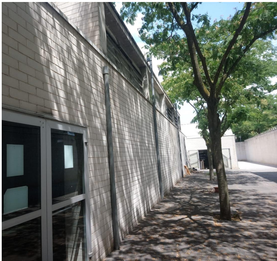
Fig. 6: Baixants de la cara sud-est de l'edifici.
