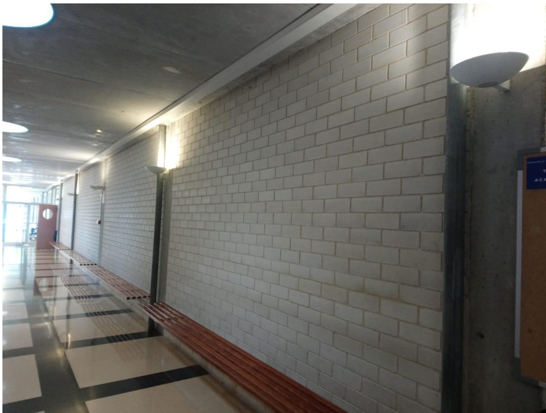
Fig. 5: Conjunt de baixants de la zona 2
