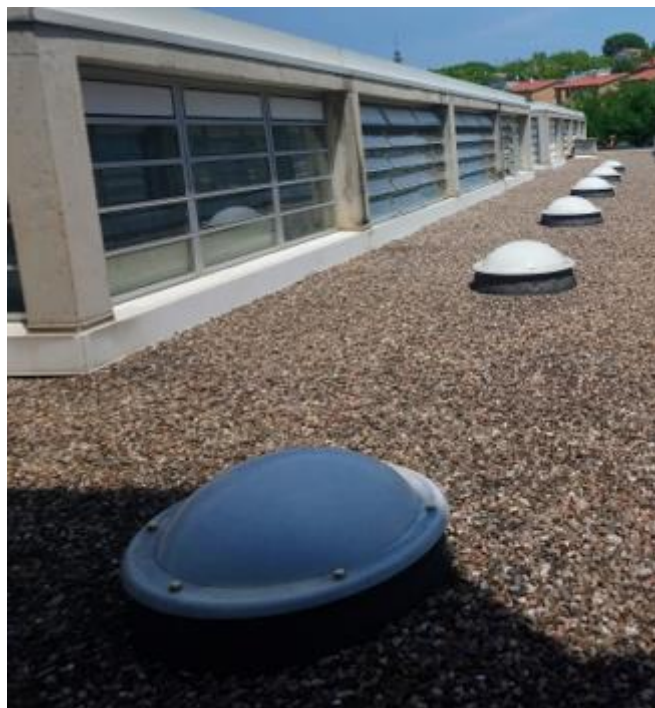
Fig. 41: Claraboies de la zona 2 en l'estat actual.
