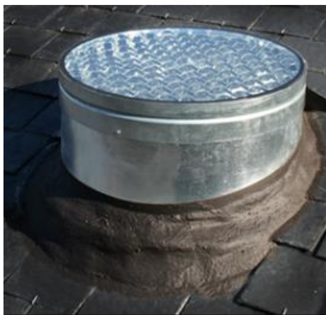
Fig. 42: Claraboia transitable rodona (aspecte que tindria prèviament a la col·locació de la tarima) (Espacio Solar, s.d.).
