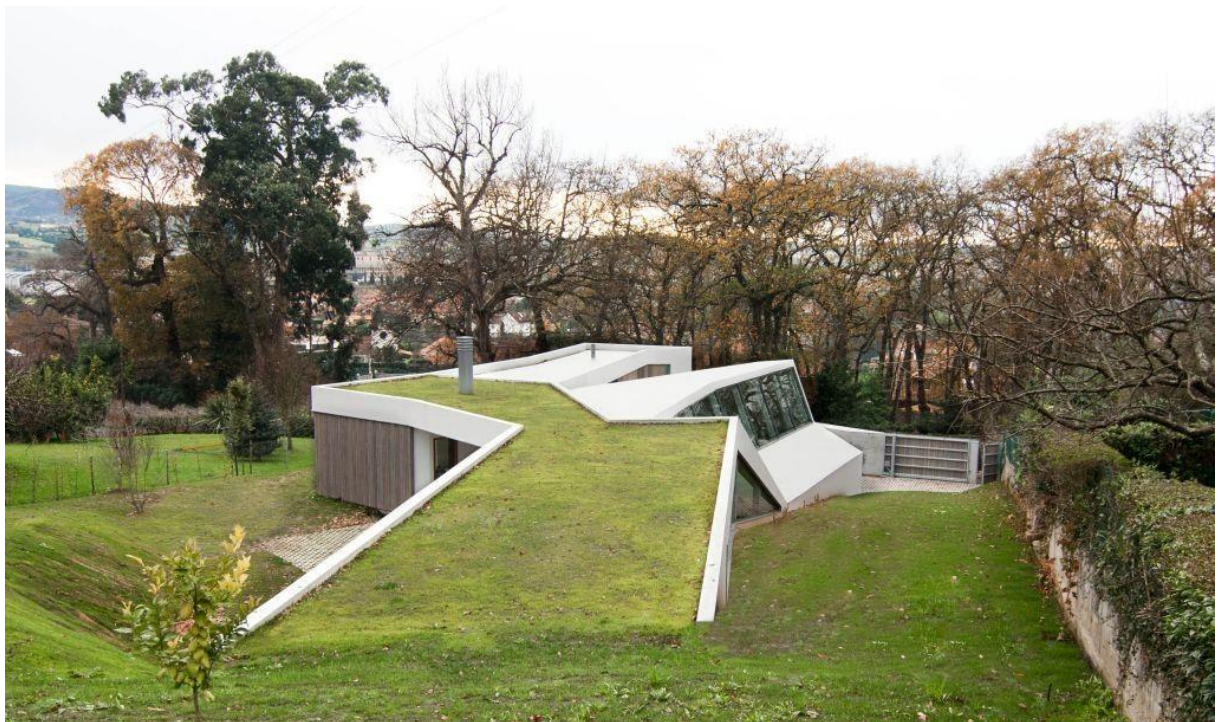
Fig. 7: Integració paisatgística de les cobertes. (F451 Arquitectura, s.d.)
