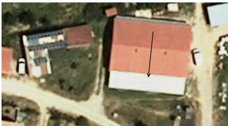
Figura 16: Teulat de l'empresa aprofitable per a instal·lar fotovoltaica.
