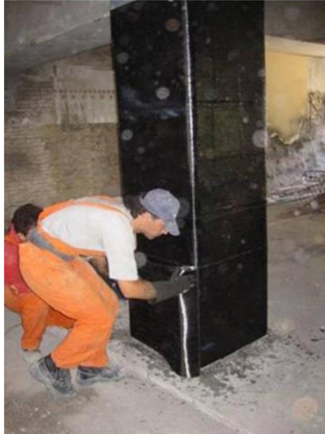
Figura 4.3. Aplicació del reforç d'un pilar de formigó armat amb CFRP [1]
