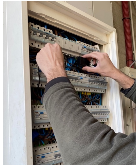
Figura 8: Procediments del muntatge i instal·lació dels mesuradors de corrent..
