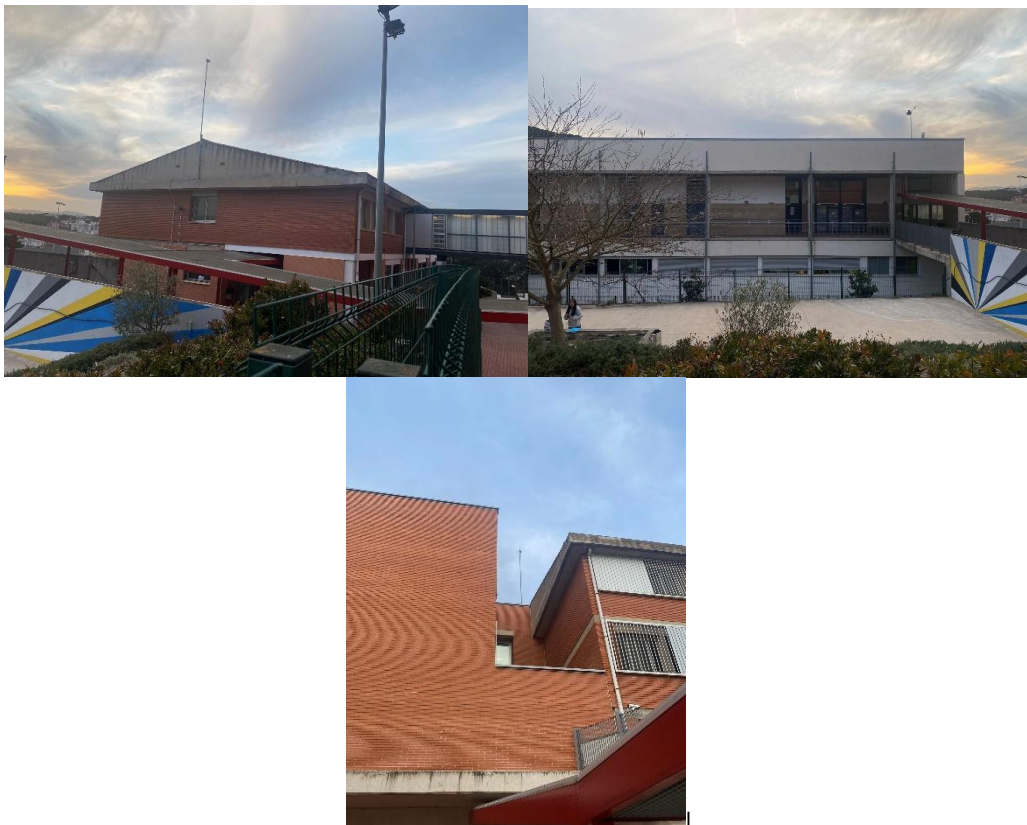
Figura 3. Vista dels diferents edificis
