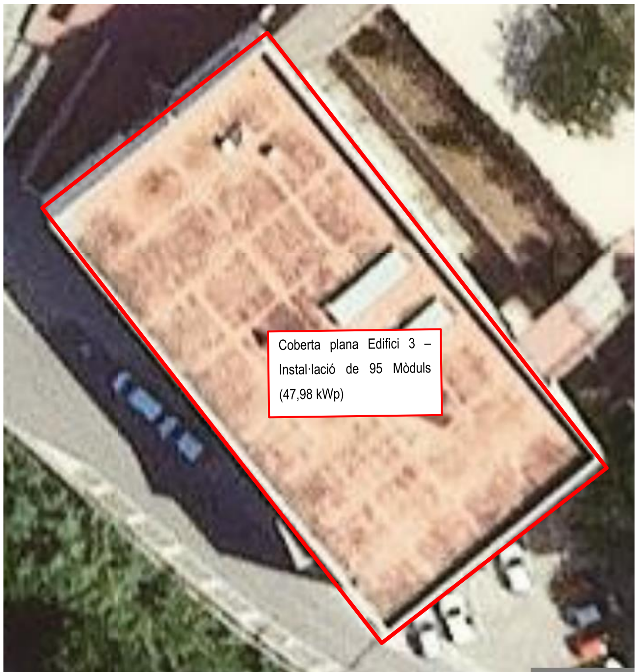
Figura 6. Coberta de l'edifici 3
