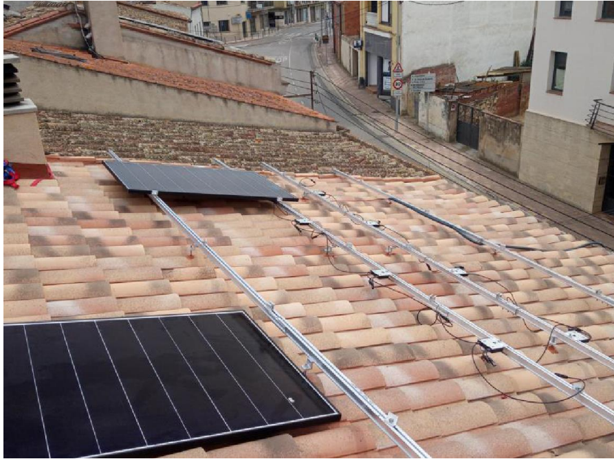
Figura 12. Estructura coplanar
