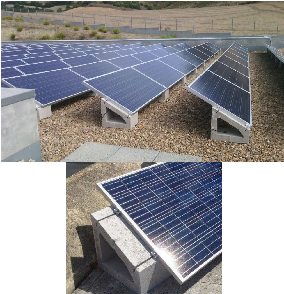
Figura 13. Estructura autollastada
