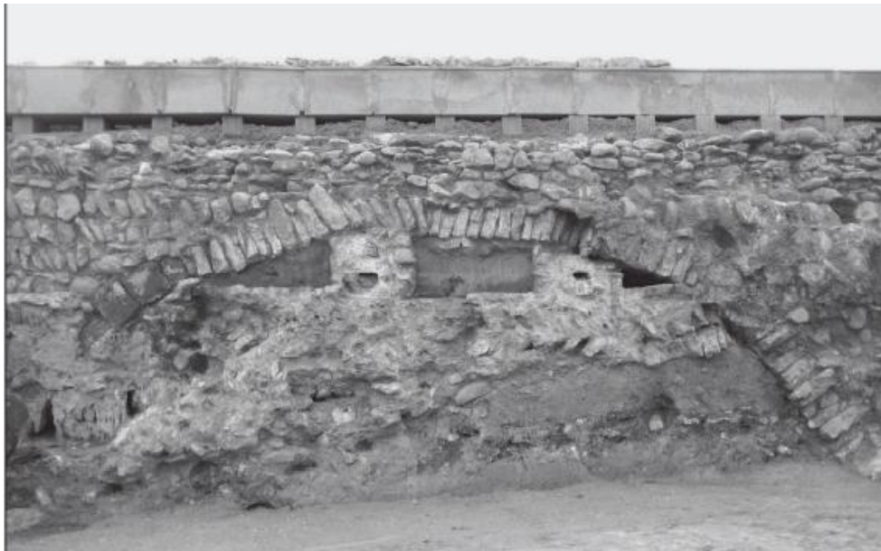
Pont de les Caixes (imatge parcial). Sota el parament medieval i modern es pot apreciar el sòl de la conducció romana, els sediments que la rebleixen i l'obra medieval associada a l'arc de descàrrega. (Remolà et al 2011, 199)
