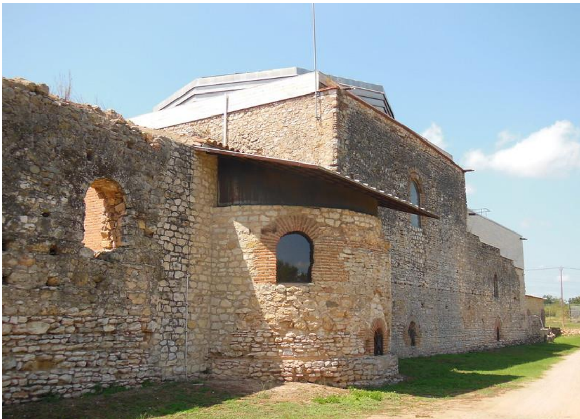
Part de la façana nord del conjunt de Centelles amb l'absis (reconstruït parcialment durant les excavacions /restauracions) de la sala 6. (Imatge extreta el dia 26 -III- MMXXII de: https://farm6.staticflickr.com/5635/20650897070_b6ca3fdbc2_c.jpg )
