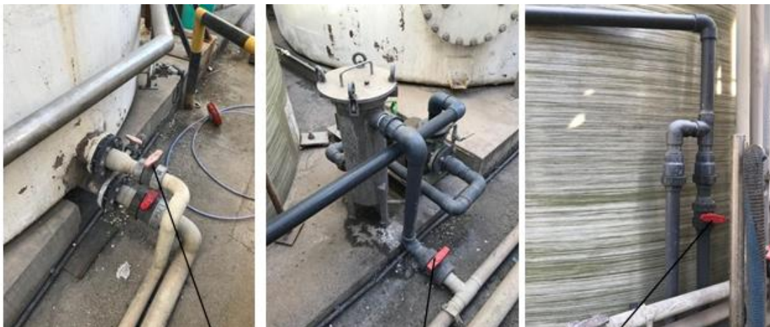
Figura 42 Vàlvules de bola per l'enviament d'aigua a l'E.D.A.R.I
