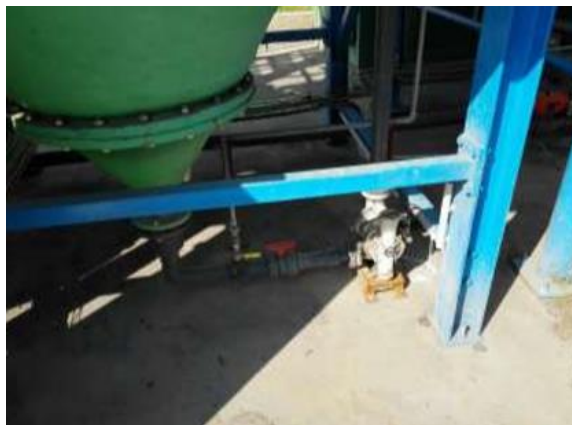
Figura 6 Bomba pneumàtica d'enviament dels fangs a l'espessidor.
