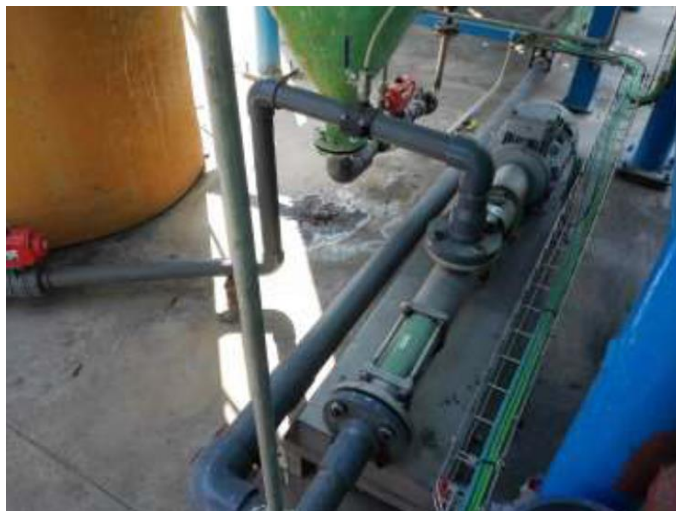
Figura 8 Bomba centrífuga helicoïdal
