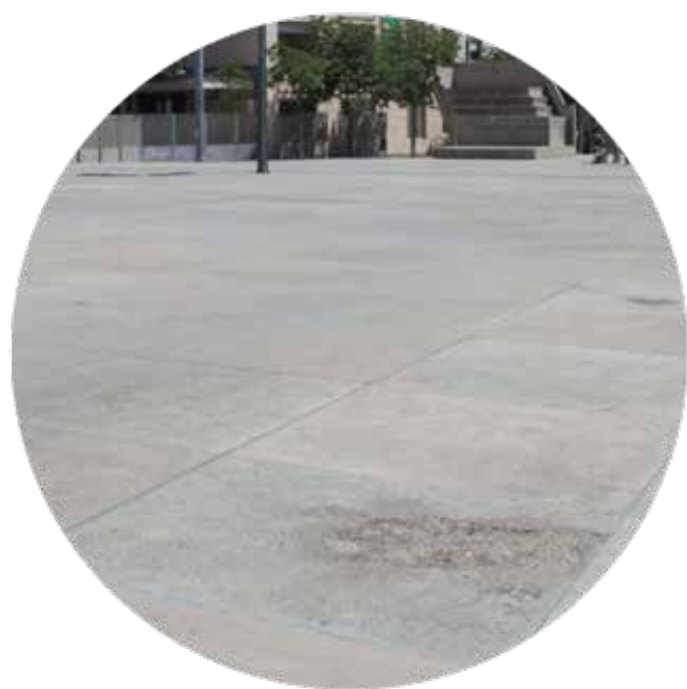
Paviment de formigó lliscat amb àrid vist
