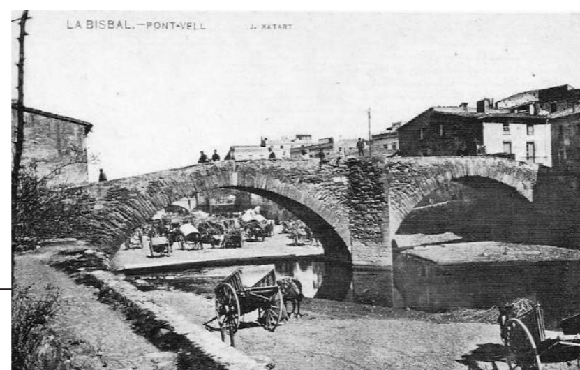
1605. Construcció del Pont Vell de La Bisbal.
