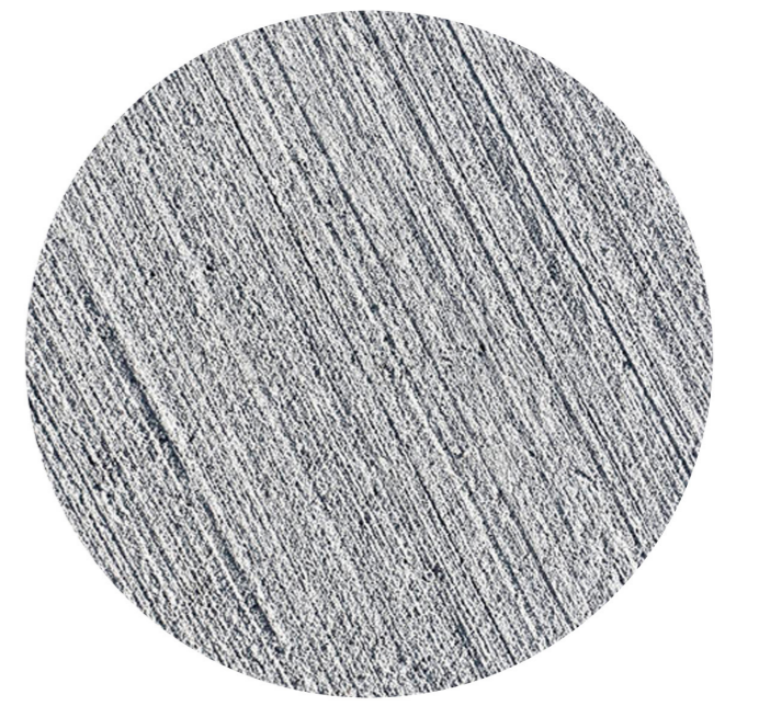
Paviment exterior de formigó raspallat
