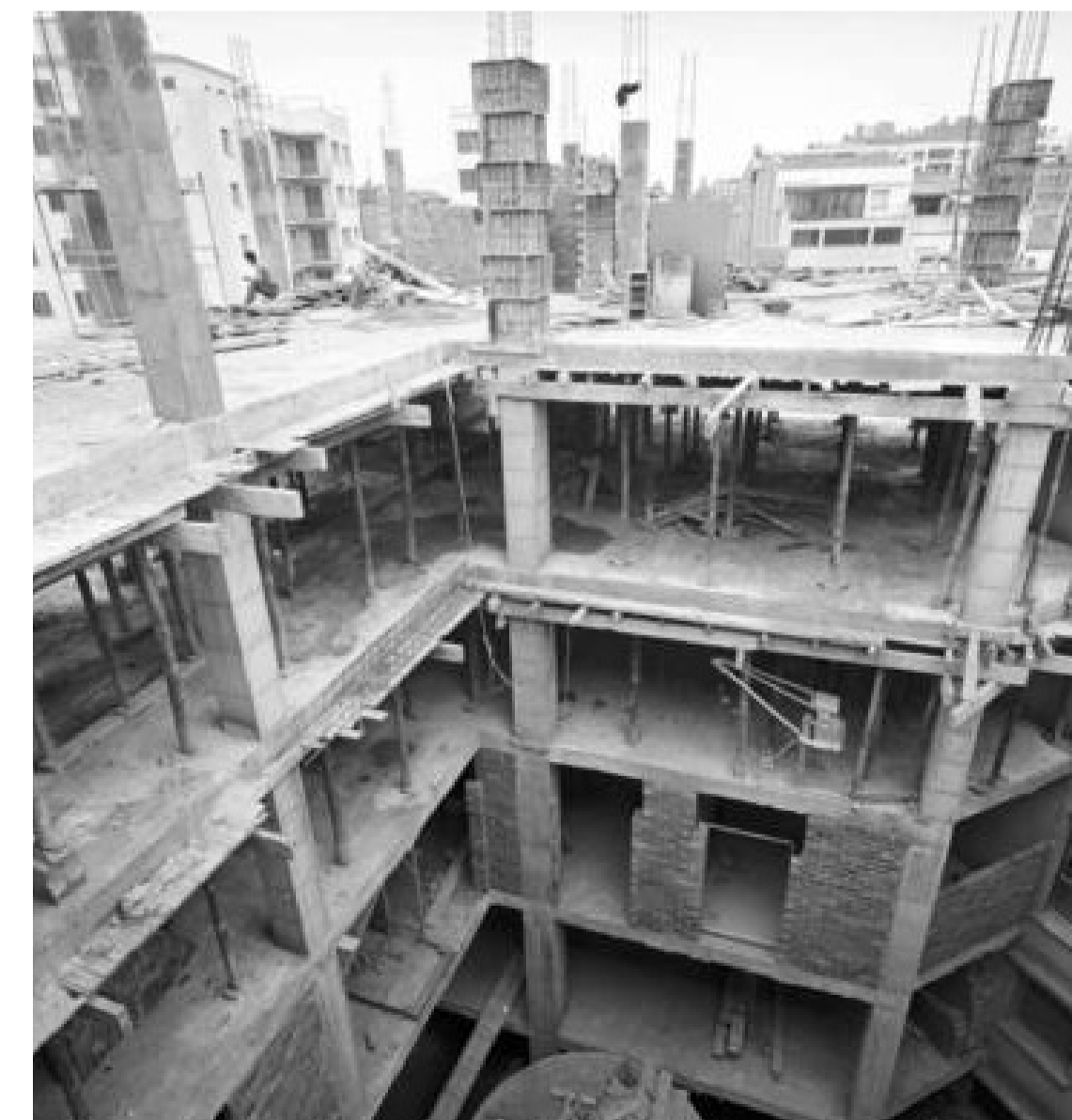
Construcció de la façana que donarà al pati interior. Vista del sistema vertical i horitzontal emprat. Ajuntament de Girona. Font OMNIA
