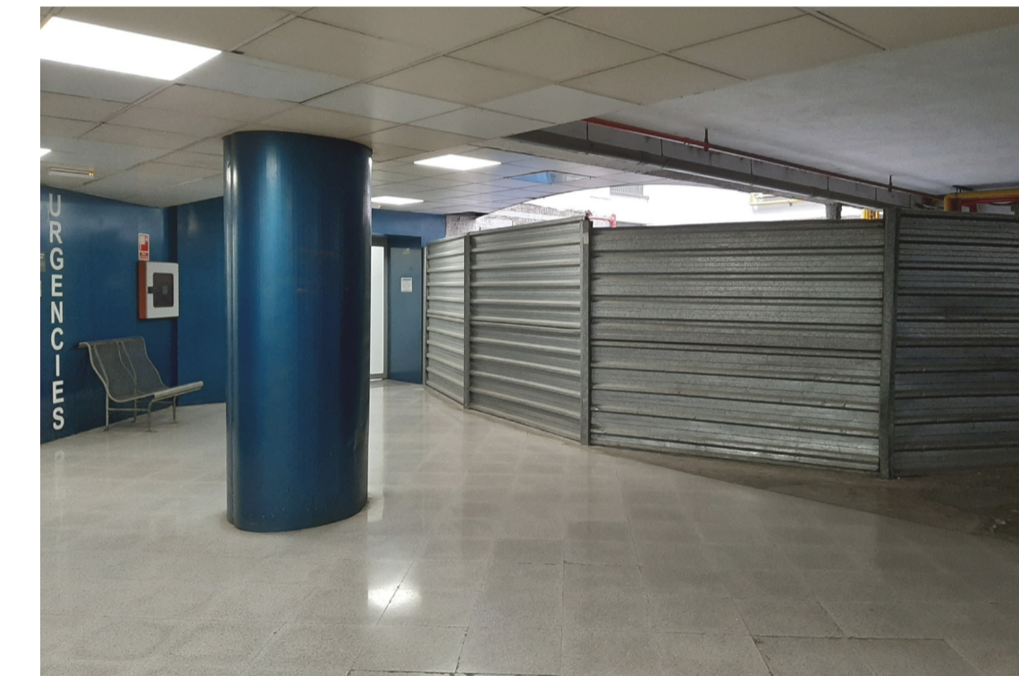
Vista del cel ras i pavimentació de planta soterrani.
