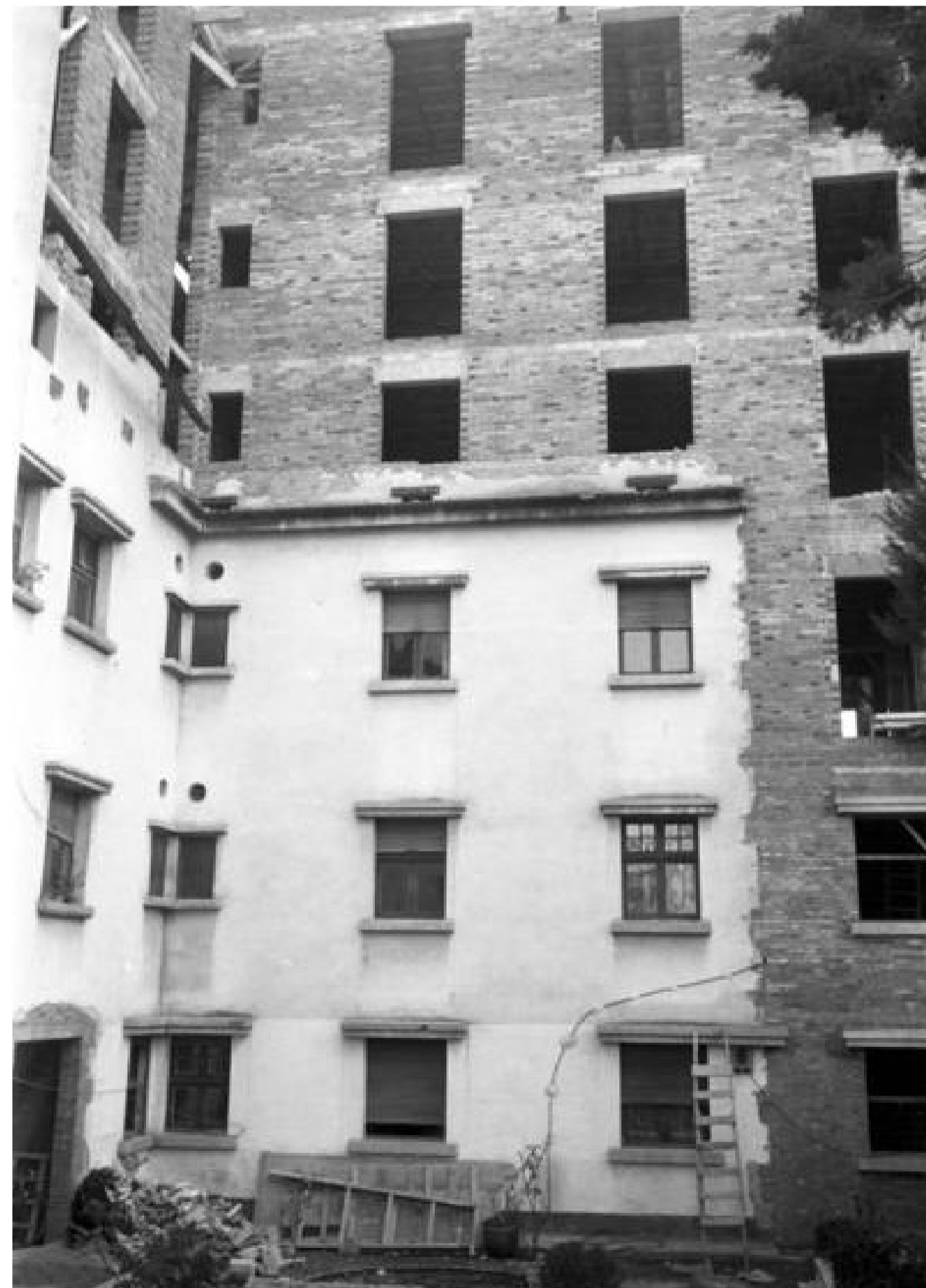
Vista de la construcció de la Clínica des del pati interior. Ajuntament de Girona. Font OMNIA
