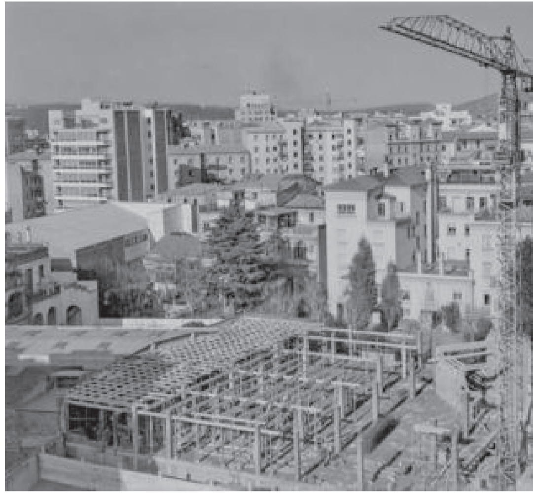
Construcció del forjat de planta baixa. Ajuntament de Girona. Font OMNIA
