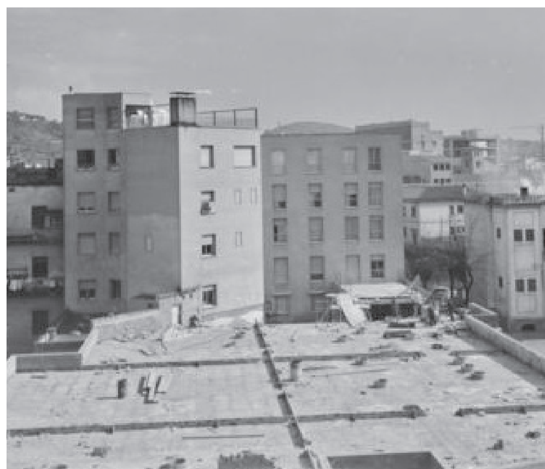
Vista del acabat del forjat de planta baixa. Ajuntament de Girona. Font OMNIA
