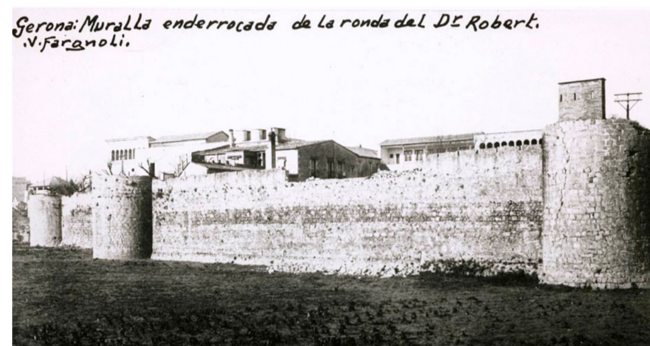
Vista parcial del tram de muralla del Mercadal compresa entre els baluards de Sant Francesc i el de Santa Clara, 1901-1910. Autor Valentí Fargnoli Iannetta. Font CRDI - Ajuntament de Girona
