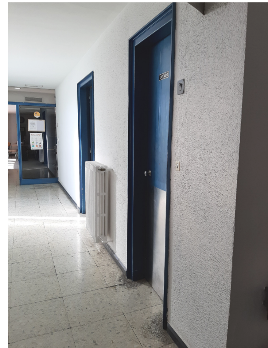
Vista d'una porta batent i parament vertical interior enguixat.
