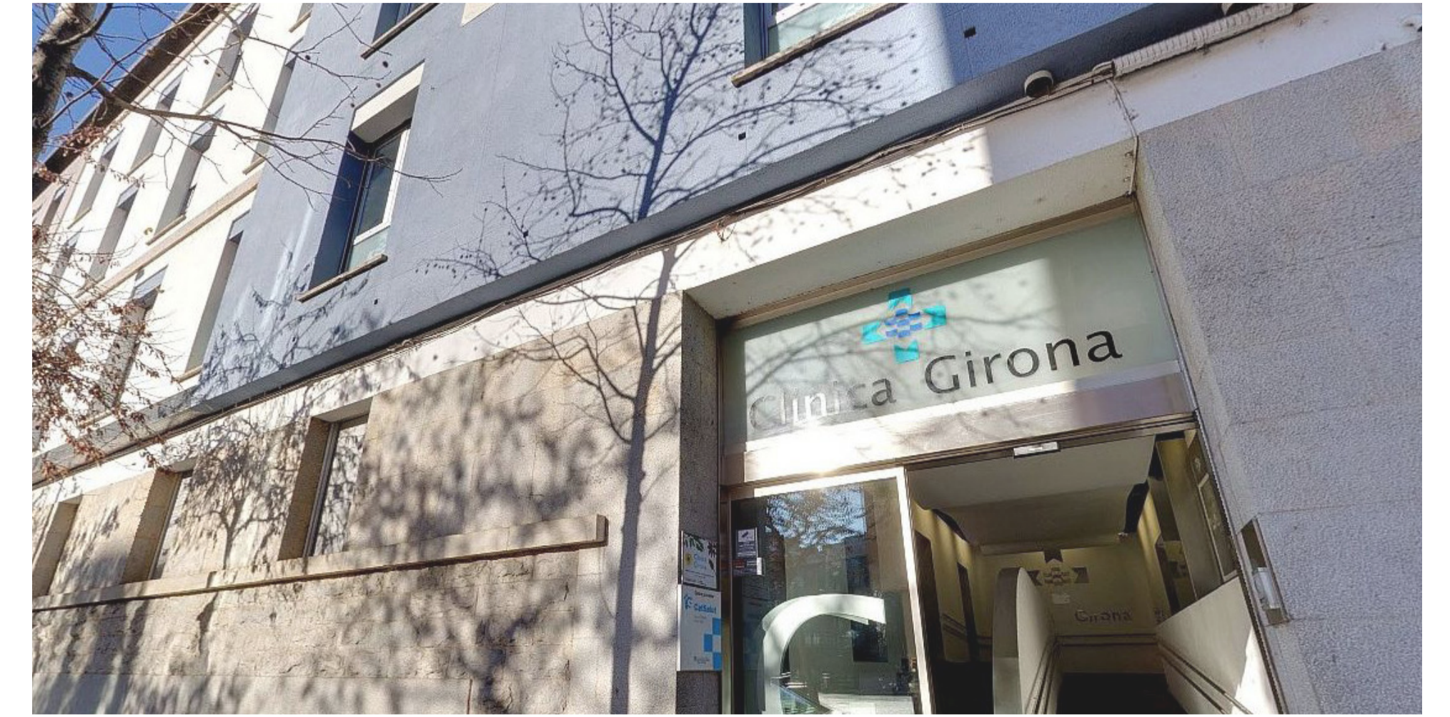
Vista dels diversos tipus d'acabats de la façana principal i de les fusteries exterior.
