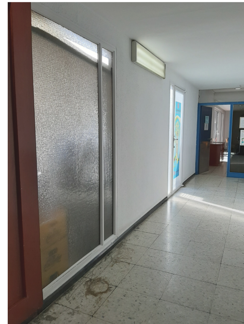
Vista de la fusteria interior d'alumini.
