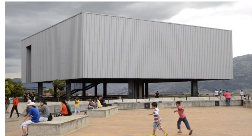
Figura 47. Colegio Antonio Derka, Medellín (Obranegra, 2008). Sala polifuncional y plaza: espacios extendidos a la comunidad.
