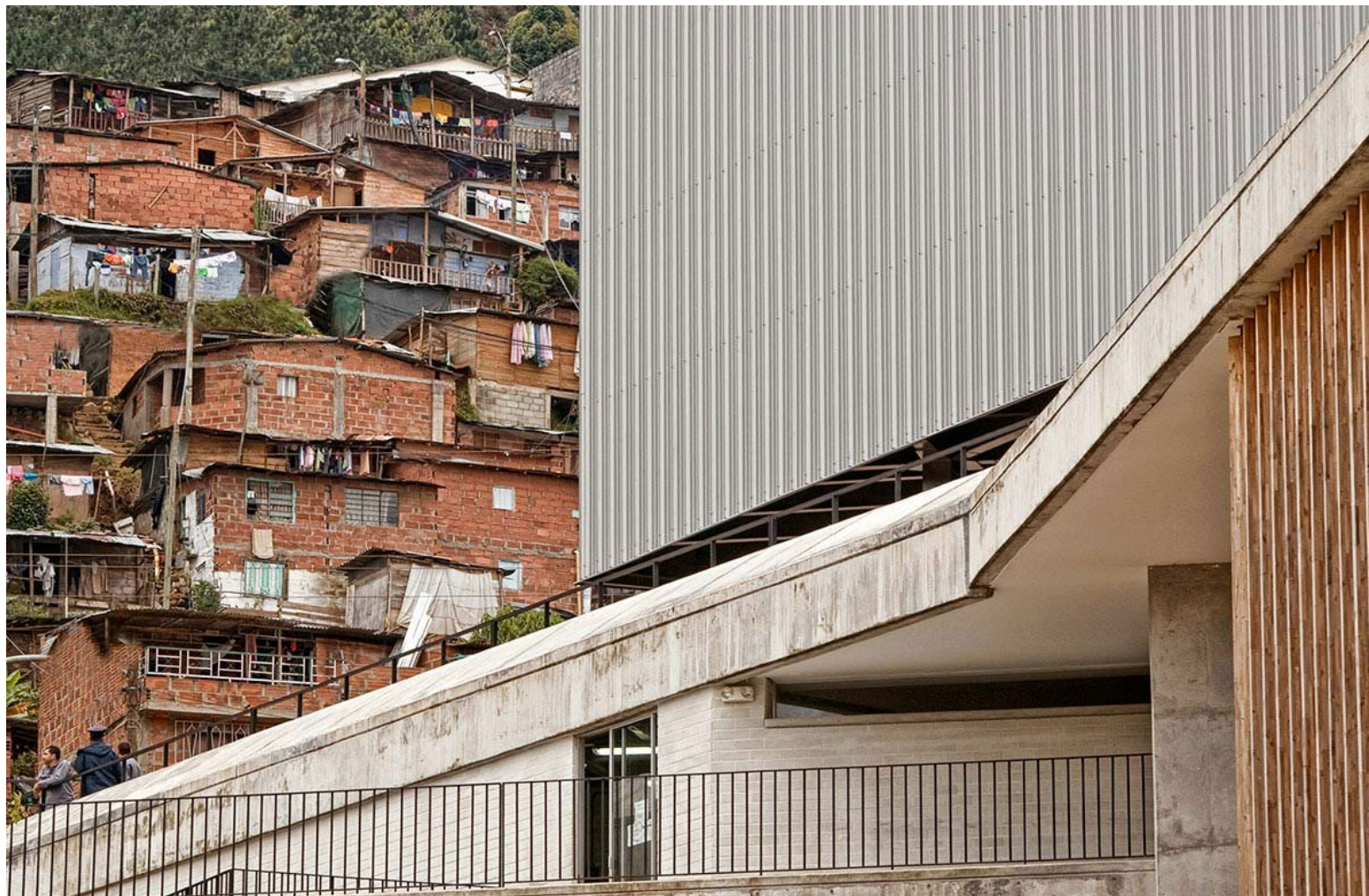
Figura 40. Colegio Antonio Derka, Medellín (Obranegra, 2008). Detalle de fachada y edificación adyacente.
