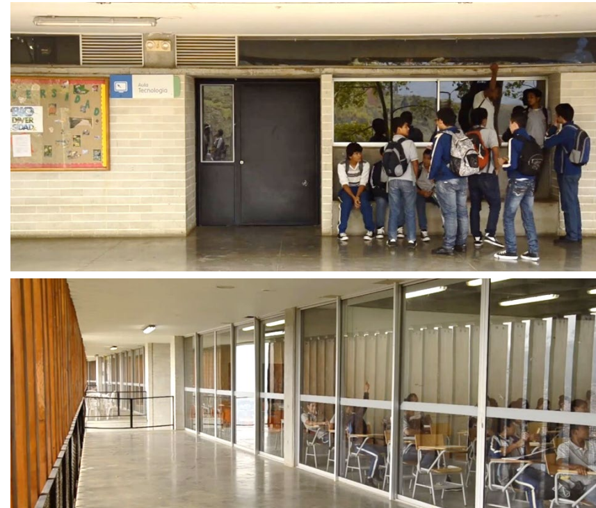
Figura 48. Colegio Antonio Derka, Medellín (Obranegra, 2008). Aulas cerradas al recorrido/umbral y abiertas a las terrazas.
