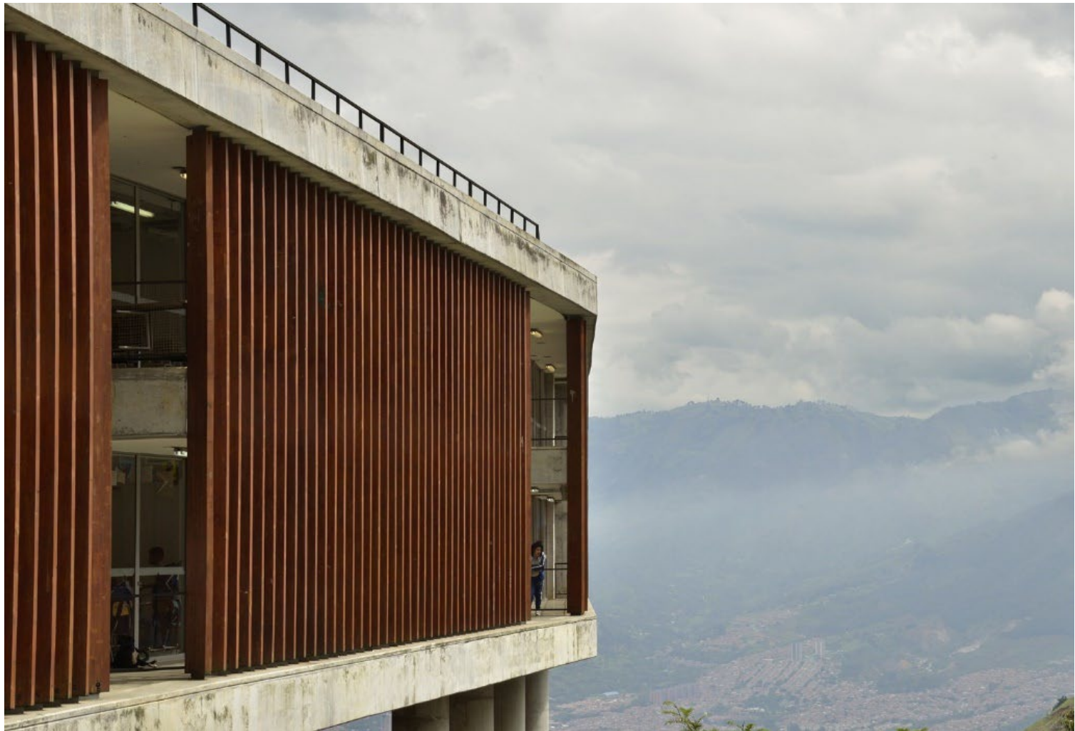
Figura 38. Colegio Antonio Derka, Medellín (Obranegra, 2008). Detalle de fachada.
