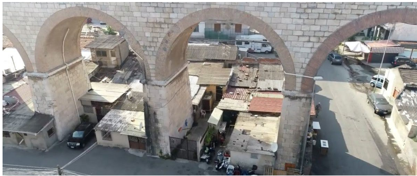
Figura 12. Las casetas temporales de Camaro (Mesina) en fase de construcción y en 2018.
