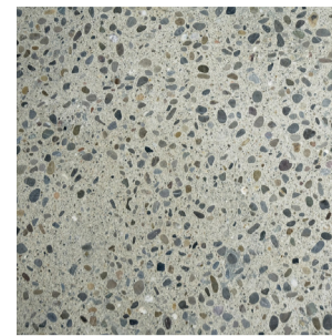
Paviment de formigó rebaixat
