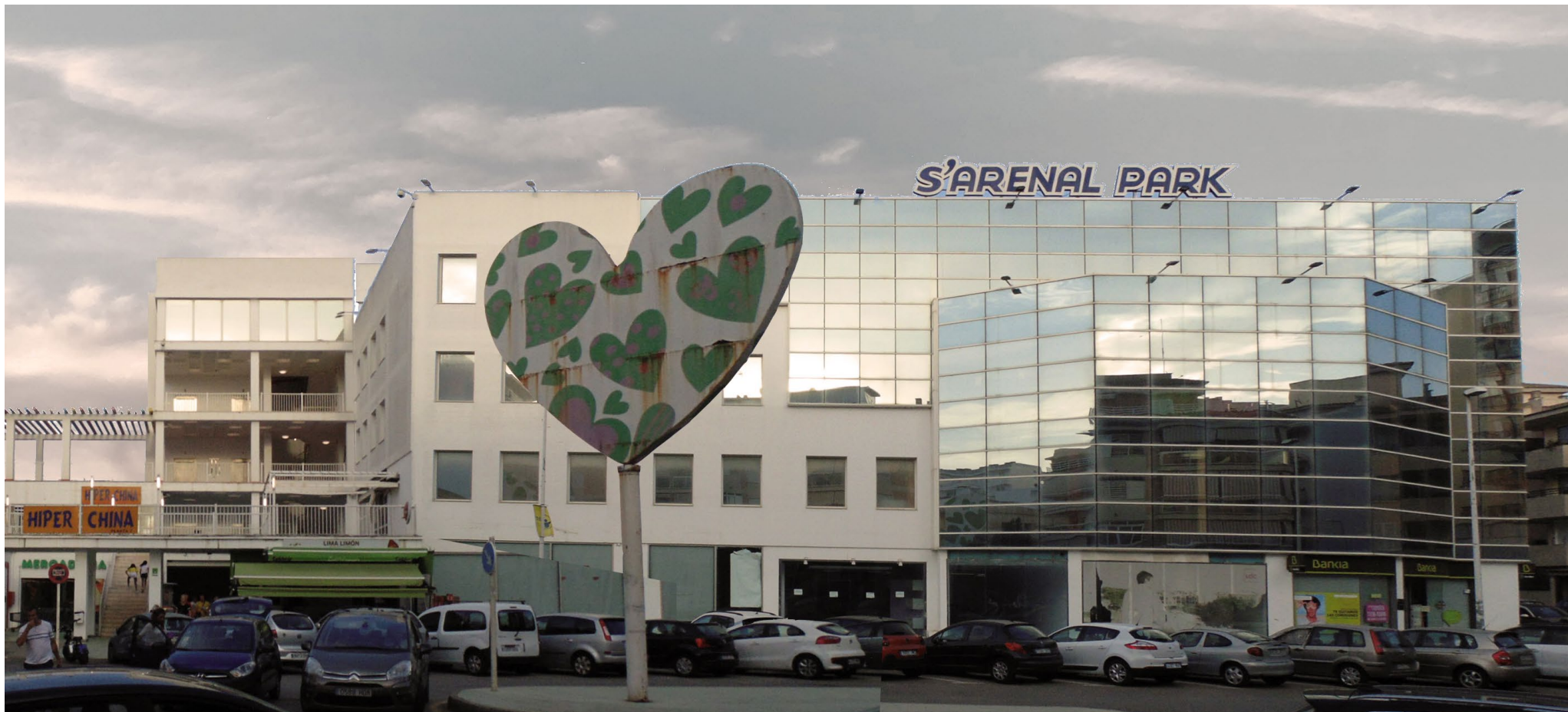
ESTADO ACTUAL DEL EDIFICIO
