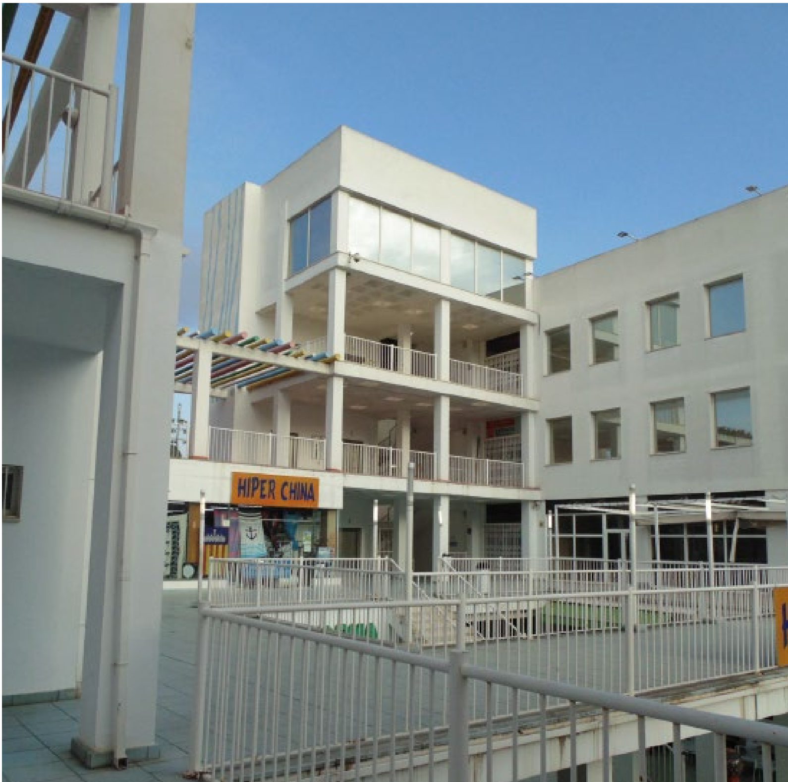
ESTADO ACTUAL, CONCEPTO ESTRUCTURAL DE INTERÉS
