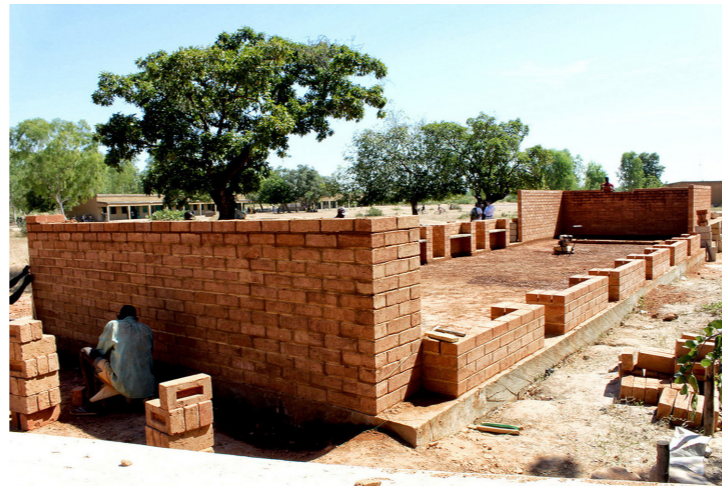
Murs de càrrega amb blocs de BTC
