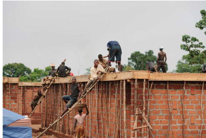
Cèrcol perimetral amb formigó armat
