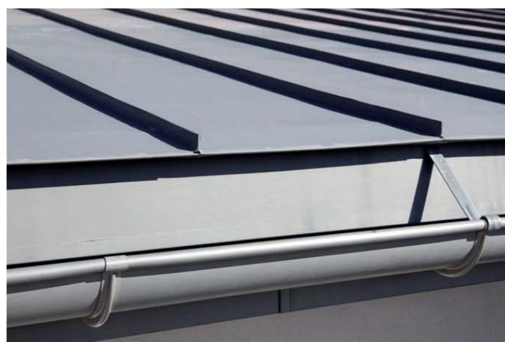
Canalització d'aigües pluvials
