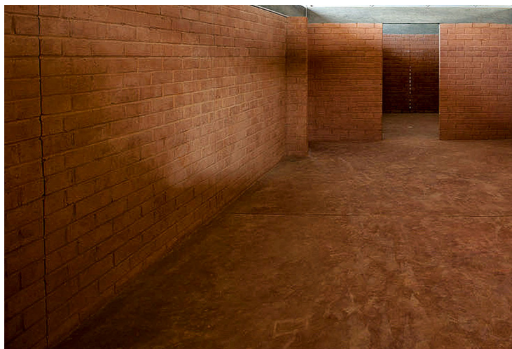
Murs interiors i exteriors Blocs de BTC vistos
