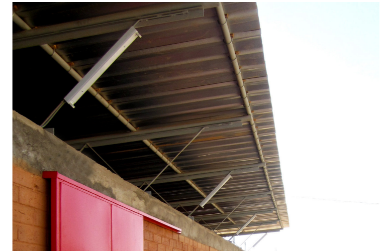
Coberta exterior Porxo amb coberta de zinc i encavallades metàl·liques
