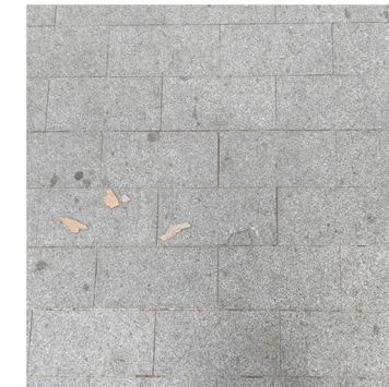
Paviment de llosa de pedra artificial
