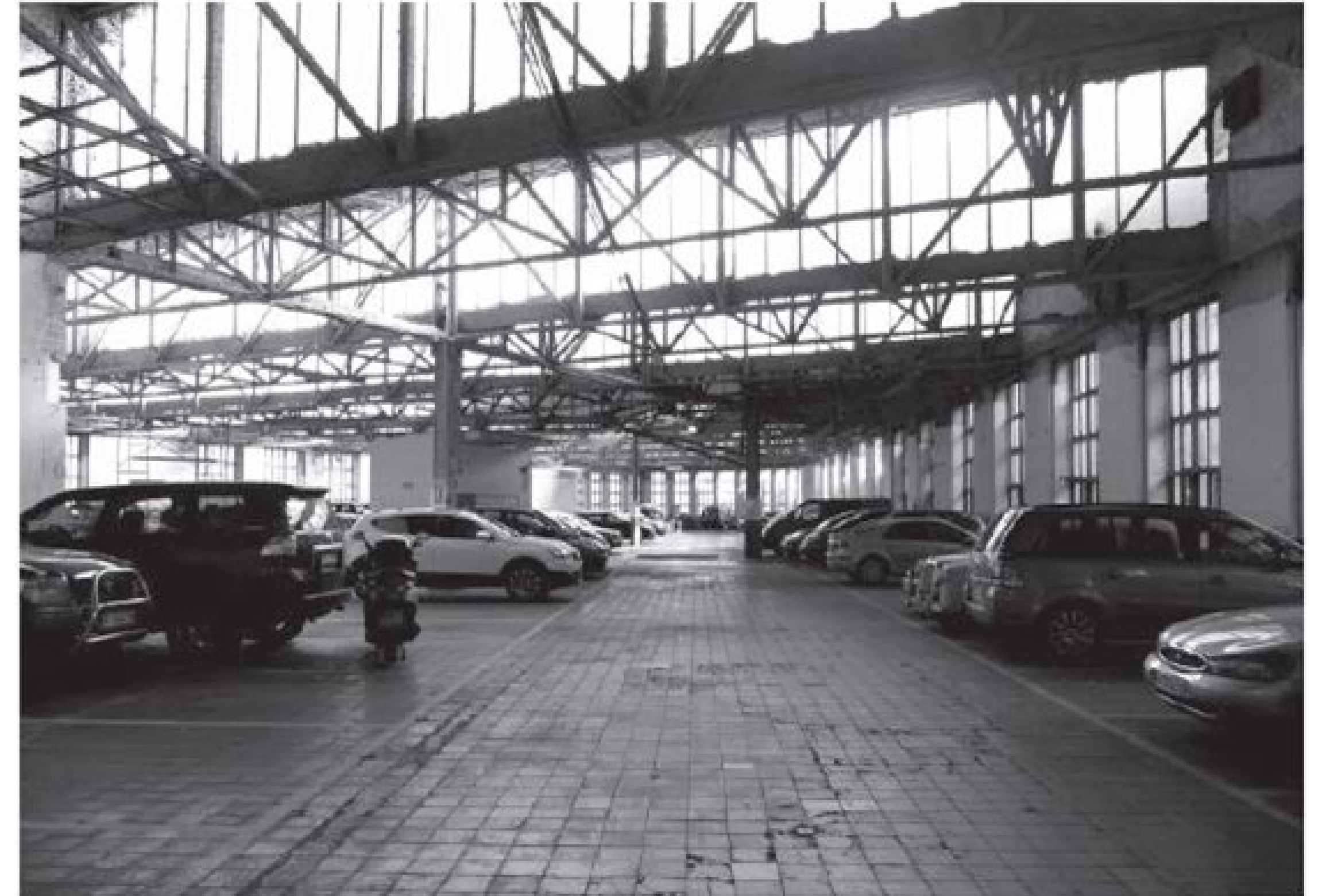
Foto interior de la nau. Font: D. García-Escudero, C. Gastón "El conjunto fabril Costa Font. La arquitectura de la fàbrica". DPA31 MITJANS
