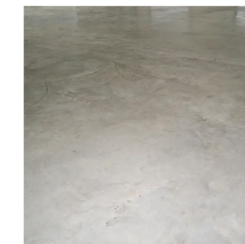
Paviment de formigó lliscat
