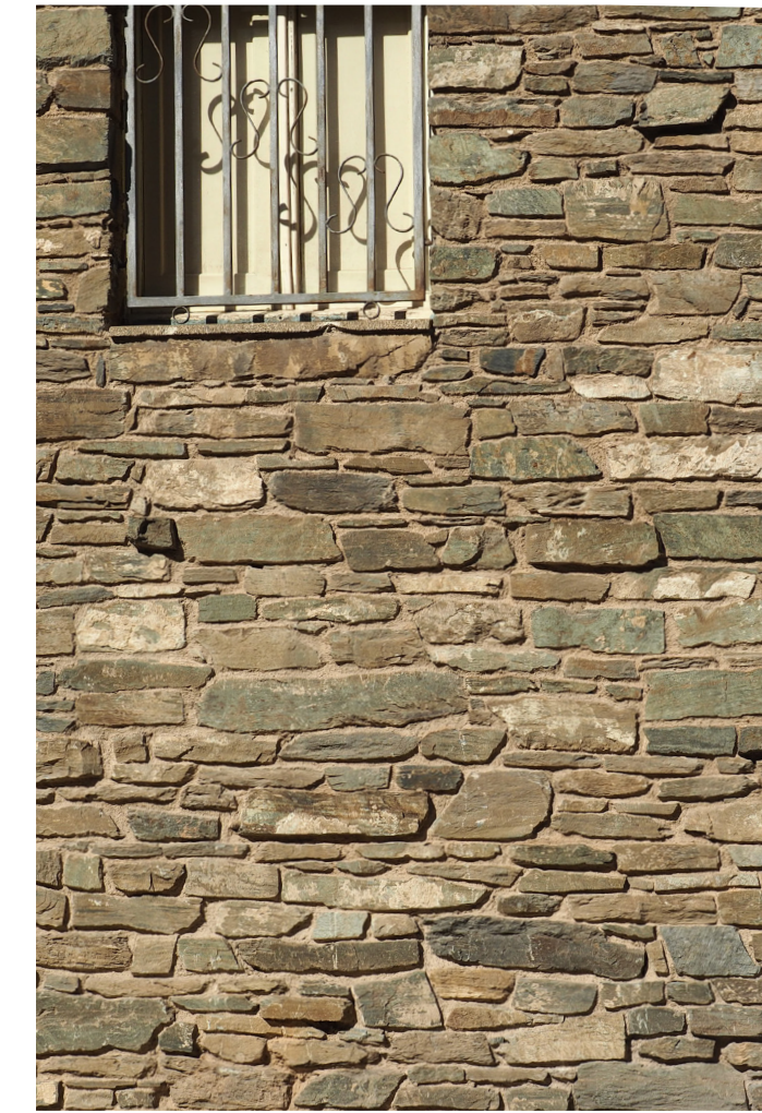
Materialitat de la Torre adossada a la nau petita de la fàbrica
