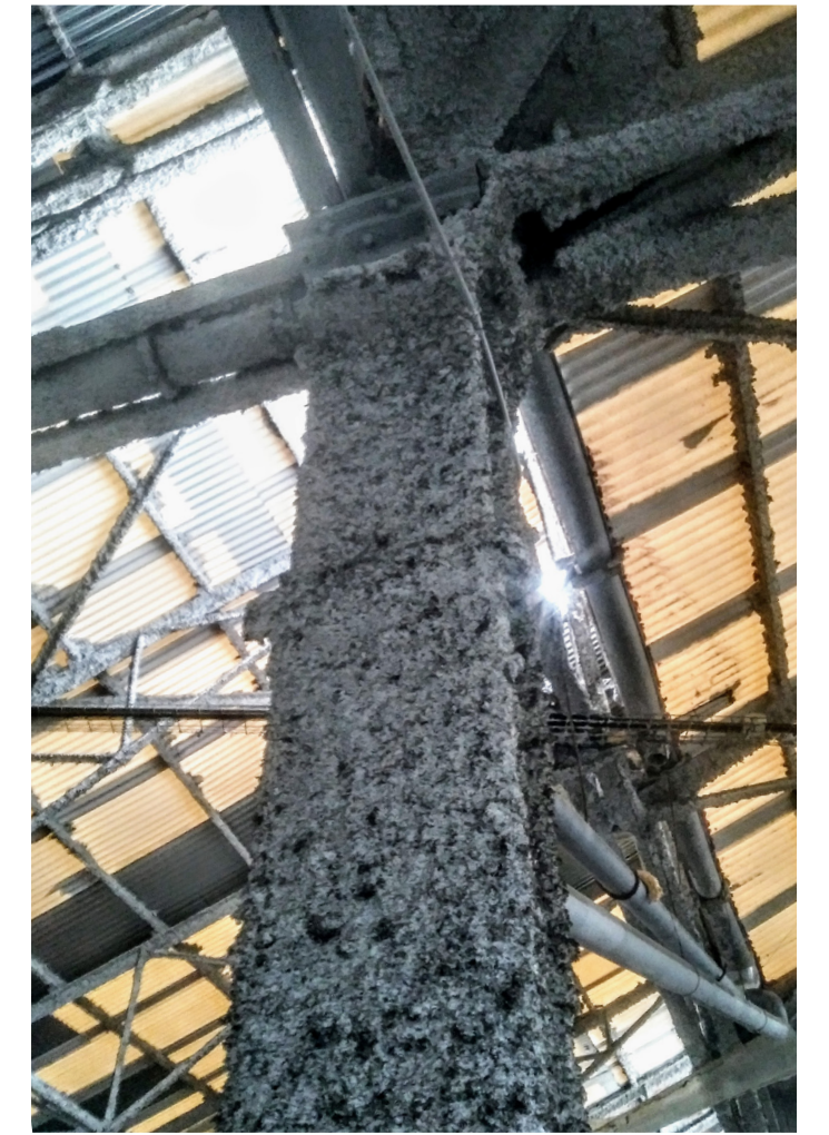
Materialitat i estructura de l'interior de la nau
