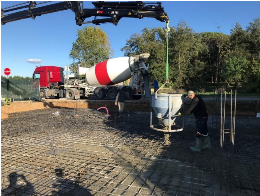
Figura 27: Fotografia formigonat llosa de fonamentació. Font: pròpia.
