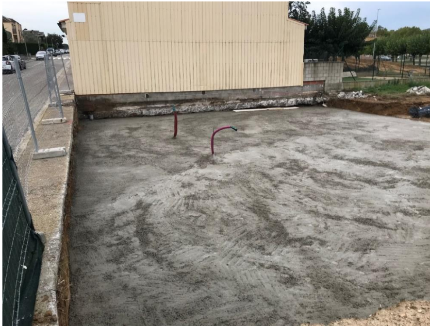
Figura 26: Fotografia formigó de neteja. Font: pròpia.
