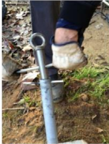
Figura 7.6: Uso de herramienta básica de desmontaje para desinstalación de Piloedre®.
