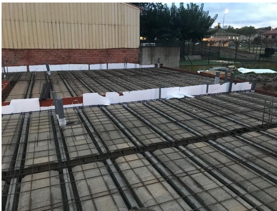
Figura 30: Fotografia forjat sanitari unidireccional. Font: Pròpia.
