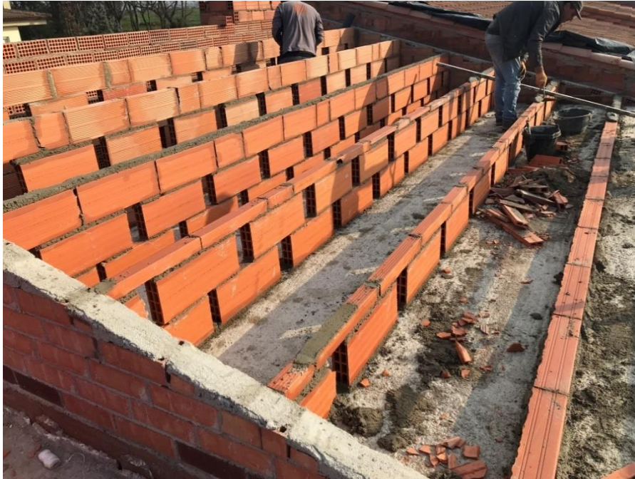
Figura 32: Fotografia del encadellat ceràmic de la coberta inclinada. Font: Pròpia.
