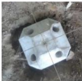
Figura 7.2: Excavación en el terreno y colocación del bloque de hormigón.
