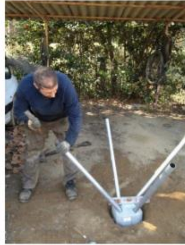
Figura 7.3: Posicionamiento y fijación del Piloedre®
