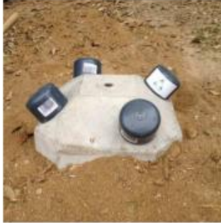
Figura 7.5: Instalación de los tapones de protección.
