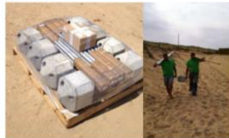
Figura 7.1: Recepción y transporte de Piloedre®.
