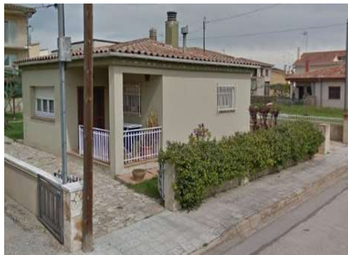
Figura 3. Imatge exterior de l'habitatge. Font: Google Maps.
