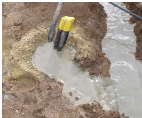
Figura 28. Sellatge d'un pou vertical. Font:Aetess.
