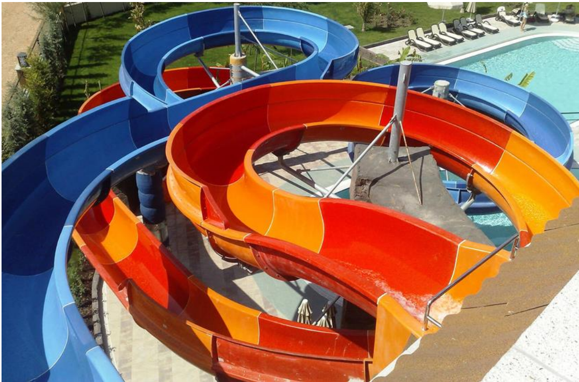
Figura 6. En la imatge s'observa que en els trams de corba el tobogan és més alt, de manera que s'evita la possible sortida del cos per la tangent. Font: Expertfun .
