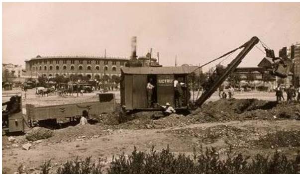
Figura 503. Màquina excavadora en els treballs de l'entrada a l'Exposició (Pérez de Rosas 1922).
