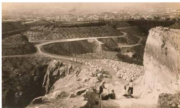
Figura 470. Construcció d'unes escales a la roca viva de les pedreres (Autor desconegut 1917).
