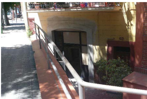
Figura 291. Vistes del desnivell existent dels accessos als habitatges del carrer de les Pedreres respecte al carrer de la França Xica (fotografia de l'investigador 2019).
