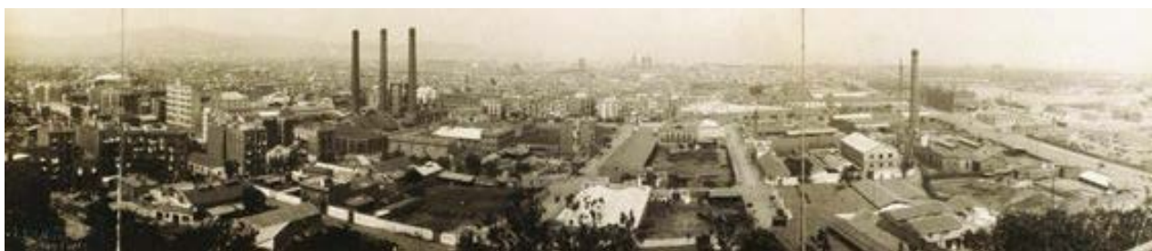
Figura 235. Vista panoràmica. Es poden observar les xemeneies de les Central de Mata i de Carrera (AFB 1920).
