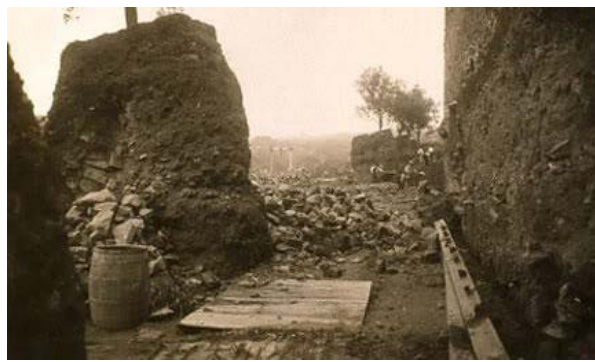
Figura 492. Passeig de Santa Madrona. Desmunt considerable per a obrir el pas, sota el traçat de l'antic camí (Roisin 1917).
