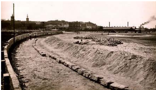
Figura 485.. Treballs d'afermat i pavimentació en el costat esquerra de l'hemicicle (Pérez de Rosas 1918).
