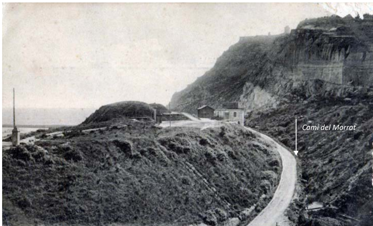
Figura 539. Inici del traçat del Camí del Morrot pels penya-segats de Montjuïc, en sentit Sud, des de la cruïlla amb el camí antic de València (Leon i Levy 1905, anotacions de l'investigador).
