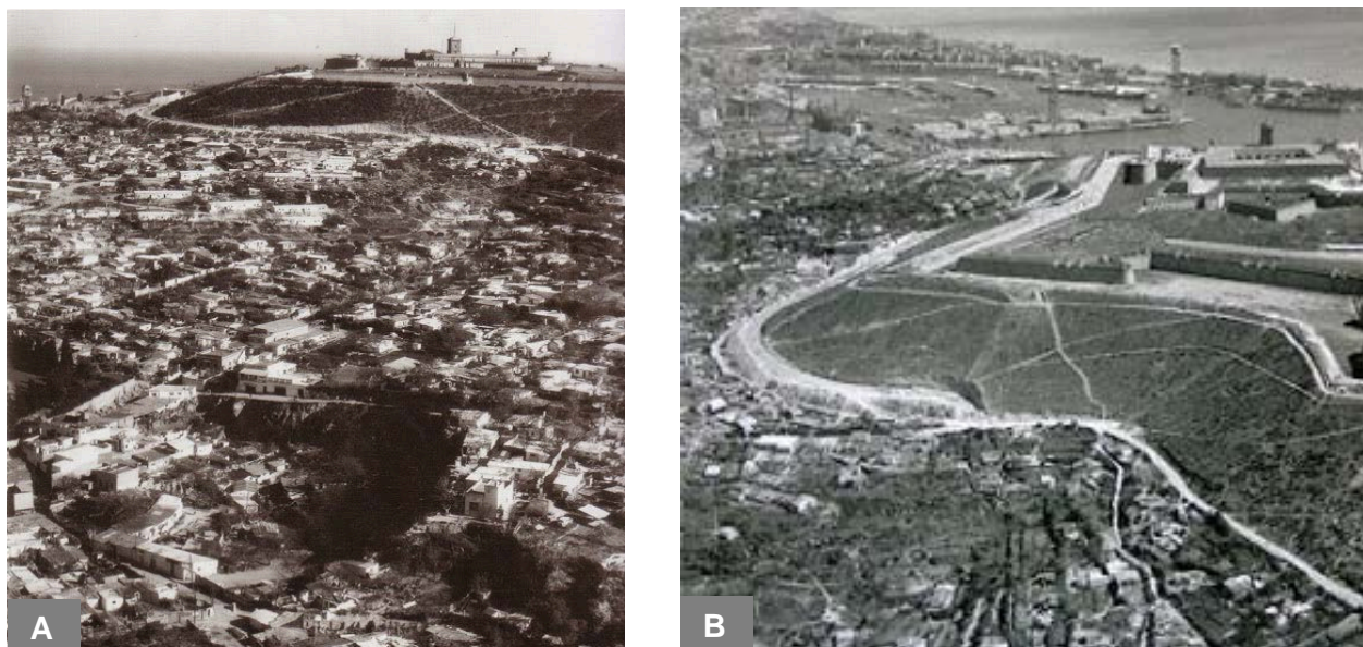
Figura 106. Vistes aèries de les barraques de Montjuïc (AFB 1950).
