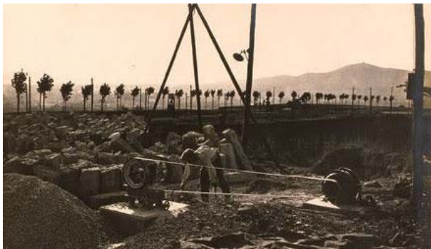
Figura 487. Maquinària Trituradora de pedra per a la fabricació de formigó (Autor desconegut 1920).
