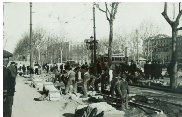
Figura 40. Empedrant la Gran Via (Balell 1906).
