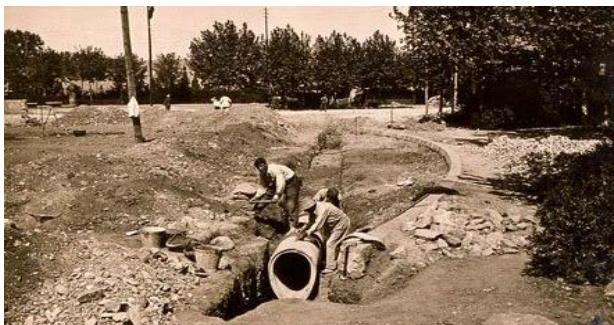
Figura 497. Construcció de la xarxa de sanejament en una de les places laterals del Passeig Central (Pérez de Rosas 1922).
