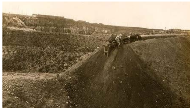
Figura 488. Avinguda del Gran salt. Formació d'un terraplè per a l'Avinguda (Roisin 1918).
