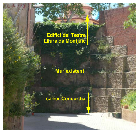
Figura 425. Vistes del mur del final del carrer de la Concòrdia. S'observa l'edifici del Teatre Lliure (fotografies i anotacions de l'investigador).
