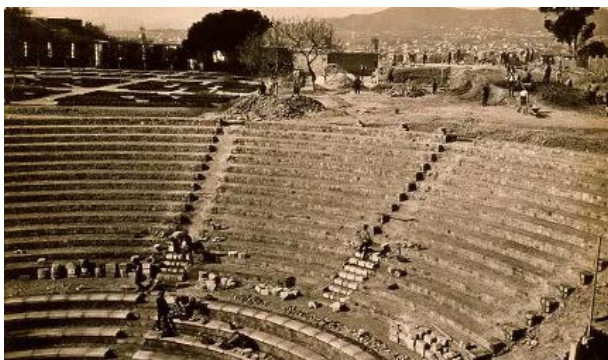
Figura 481. Reforma del Parc Laribal. Construcció graderia del Teatre Romà (Pérez de Rosas 1923).
