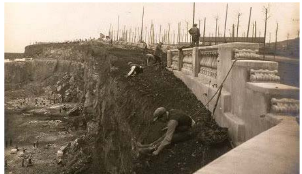
Figura 478. Construcció de les obres de fàbrica del Passeig Central Fuixarda (Roisin 1919).
