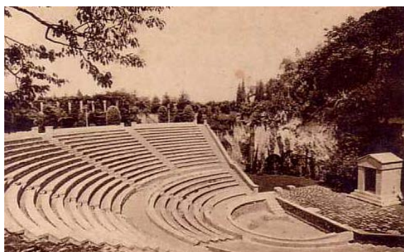
Figura 148. El Teatre Grec finalitzades les obres de construcció (AFB 1929).
