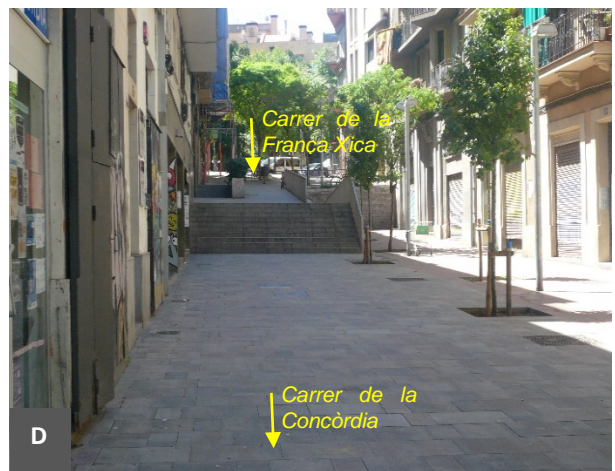
D Carrer de la Concòrdia es pot observar el desnivell important en aquest tram comprès entre el carrer Mare de Déu del Remei i el carrer de la França Xica.
