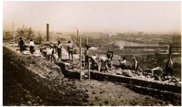
Figura 476. Construcció del mur de contenció de la gran terrassa (Ferran 1920).
