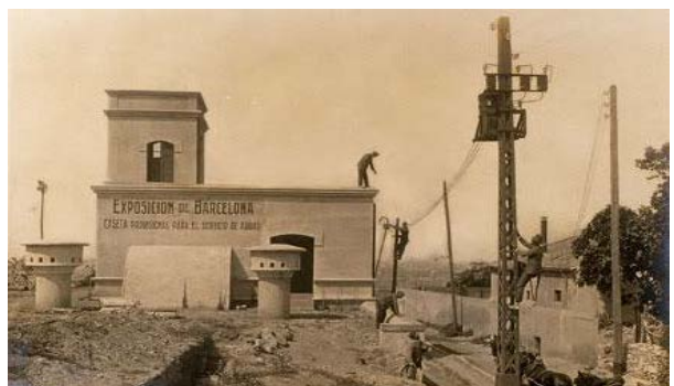
Figura 506. Treballs Preparatoris per la instal·lació de transformador (Autor desconegut 1912).
