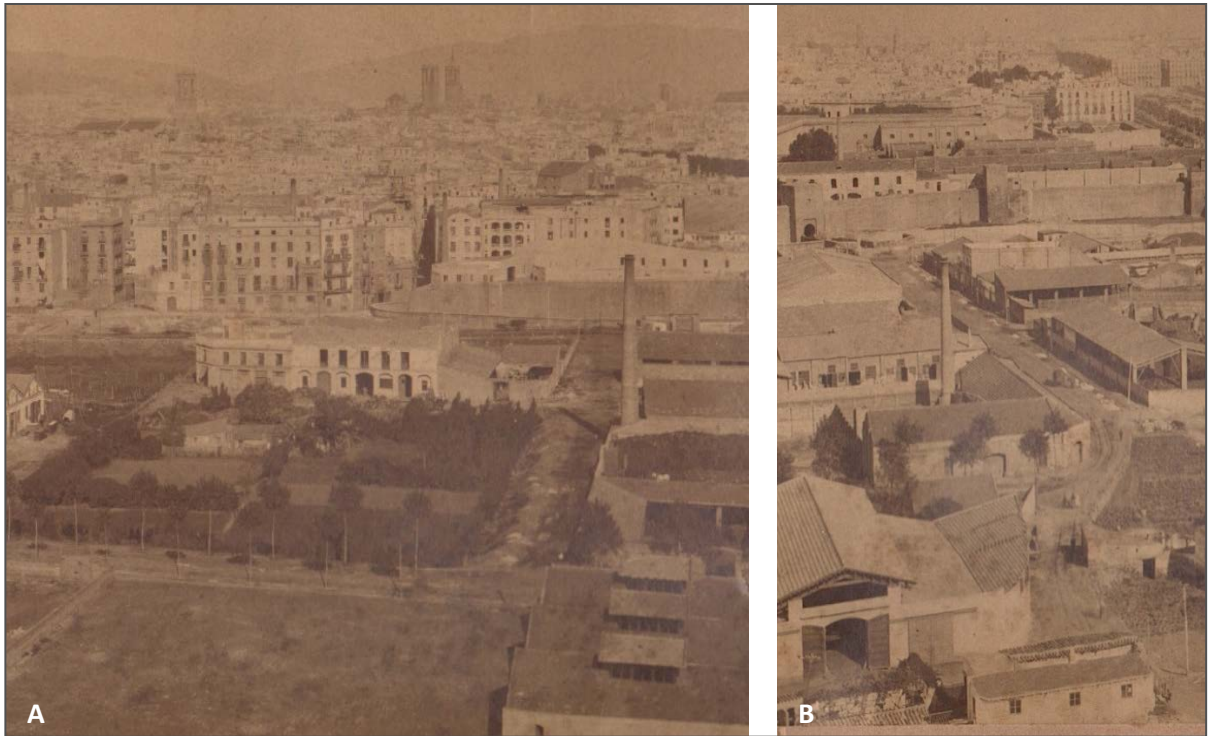
Figura 359. A i B. Vistes de detall del sector més marítim de les Hortes de Sant Bertran a l'any 1890. La Central Tèrmica del carrer Carrera encara no s'havia construït (AFB, anotacions de l'investigador).
