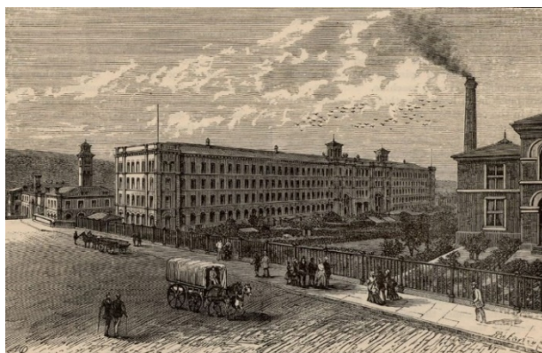
Figura 59. No hi ha cap imatge de l'època de la fàbrica Bonaplata; el seu aspecte podria ser semblat al d'aquesta il·lustració que es mostra a la publicació (Santacana 2015).
