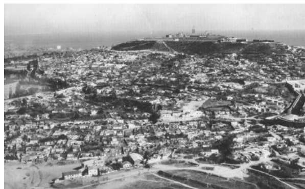
Figura 102. Creixement accelerat dels assentaments de Barraques a Montjuïc (AFB 1950).
