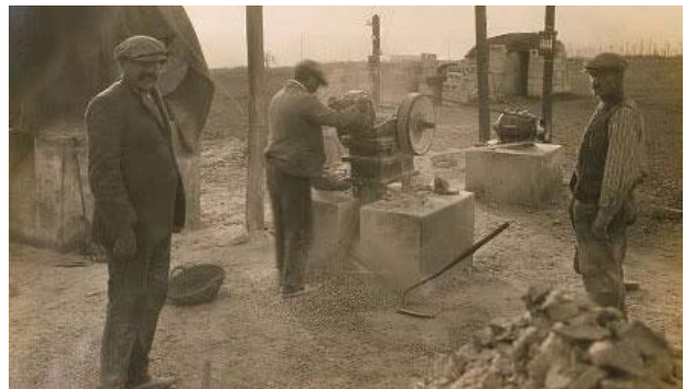
Figura 486. Instal·lacions electromecàniques. Maquinària de fer grava funcionant (Roisin 1917).
