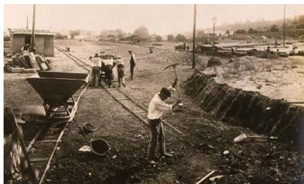
Figura 494. Primeres obres d'explanació de la Plaça de les Belles Arts (Roisin 1912).
