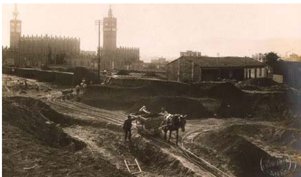
Figura 491. La vall oberta per a la construcció de l'enllaç del Parc Central amb la Gran Avinguda d'entrada (Roisin 1917).
