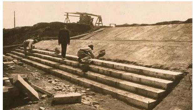
Figura 480.. Construcció de l'escala d'unió entre l'Avinguda triomfal i la Plaça de Belles Arts (Brangulí 1918).
