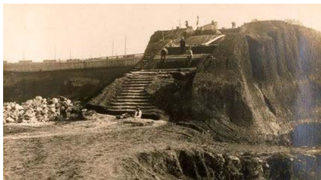
Figura 474. Construcció de la volta de l'escala en el coll entre les pedreres Gran i Prat (Roisin 1918).
