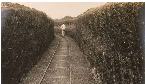
Figura 473. Ferrocarril per al servei de les obres. Instal·lació de la via que porta a la pedrera Mussol (Roisin 1917).
