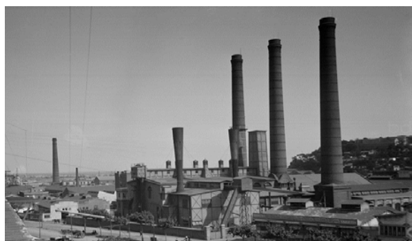
Figura 233. Vista general de la central amb les tres xemeneies. Al fons, la central d'electricitat del c/Carrera (AFB 1920).
