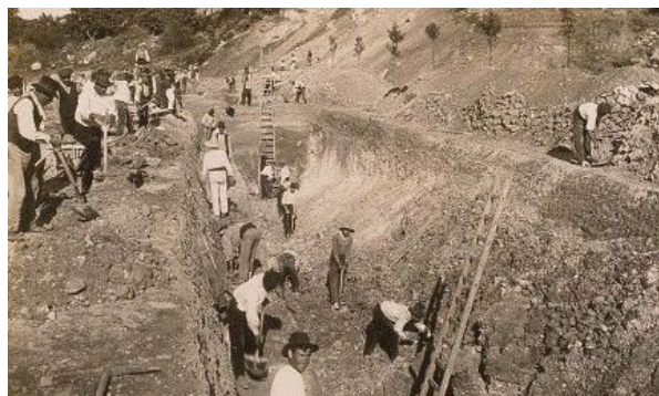
Figura 496. Treballs de construcció del col·lector de sanejament del Passeig Central (Autor desconegut 1912).
