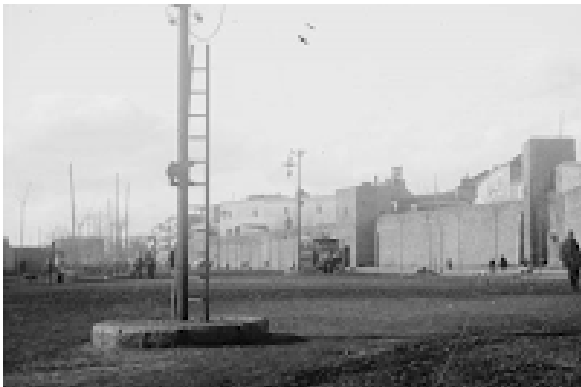
Figura 559. Vista del futur vial de l'Avinguda del Paral·lel a l'alçada del Portal de Santa Madrona (AFB 1892).
