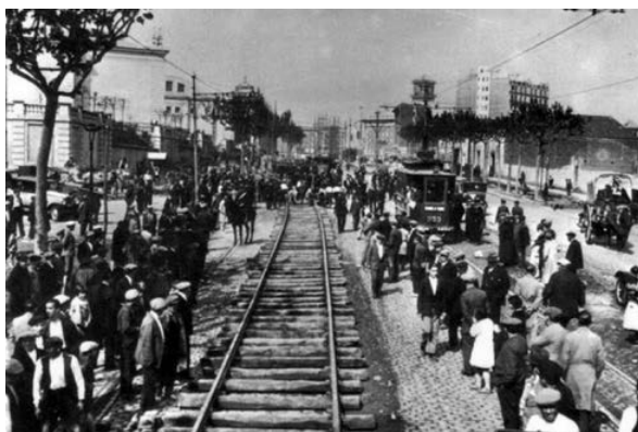
Figura 569. Tren circulant per la calçada de l'avinguda del Paral·lel, transportant materials per a l'exposició, en el seu tram final al carrer Lleida (AFB 1928).
