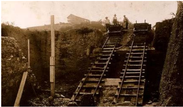
Figura 483. Funicular principal per a l'extracció de terres a Miramar (Godes 1920).
