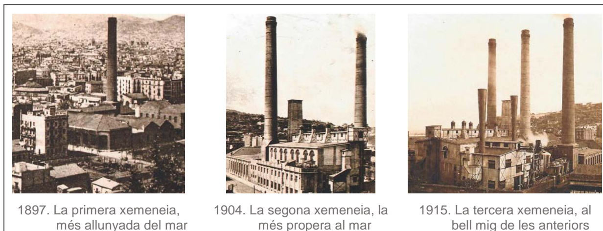
Figura 232. Evolució de la construcció de les xemeneies de la central del carrer Mata (AFB).
