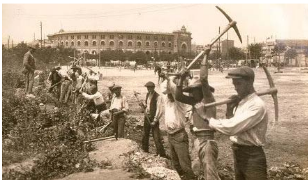
Figura 495. Hemicicle d'entrada i Gran Avinguda. Petit desmunt per anivellar l'Hemicicle d'entrada (Roisin 1918).
