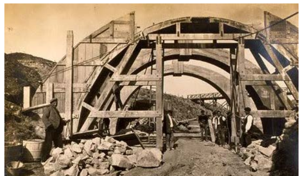
Figura 482. Avinguda del Gran Salt. Construcció d'un pont de ciment armat (Roisin 1918).
