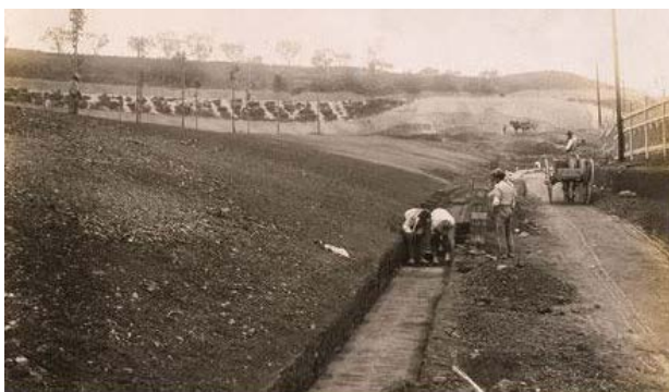
Figura 493. Construcció de la cuneta al peu del talús del Passeig Central (Roisin 1917).
