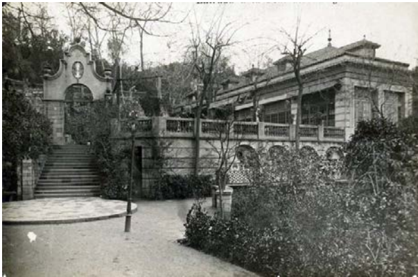
Figura 208. L'entrada de la Font del Gat a principis del segle XX (AFB 1930).
