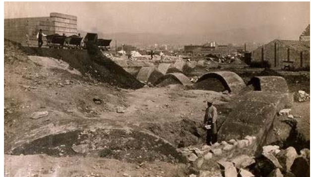
Figura 484. Construcció de fonaments per a la formació d'una plaça en l'Avinguda dels Oficis (Roisin 1918).
