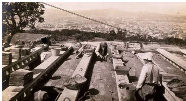
Figura 498. Instal·lacions pel servei d'aigües. Construcció de les bovedilles (Roisin 1919).
