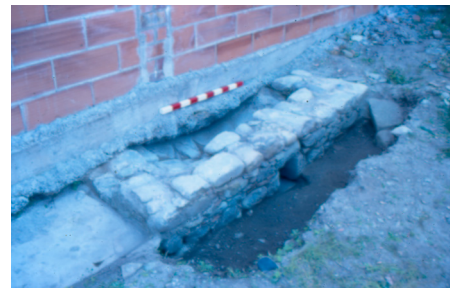
Figura 3. Vista del frontal del dipòsit amb el desaigua al centre del mur. Foto: autors.
