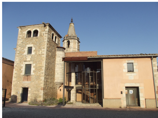
Figura 1. Façana oest del mas a l'actualitat. Al fons el campanar de l'església. Foto: autors.
