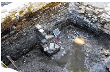
Figura 21b. Ex-convento di San Giobbe. Fognolo in muratura pavimentato con assi in legno.
