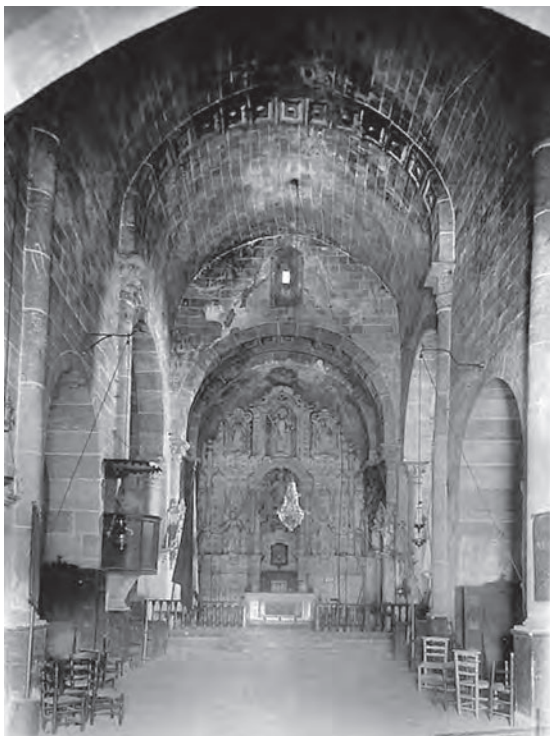
Fig. 9. Vista de la nau central. Còpia en paper utilitzada per a la sol·licitud de subvenció per a la restauració de l'església. Autor desconegut. Arxiu Diocesà de Girona.
