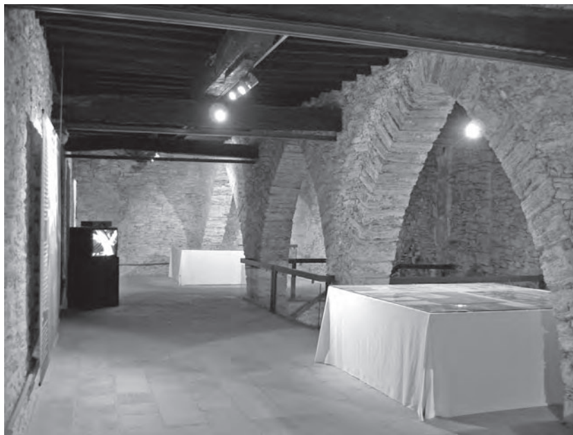
Fig. 4. Imatge de l'edifici del Tint de Banyoles, probablement construït al segle XVI al rec dels Tints (rec Major) amb reformes posteriors.
