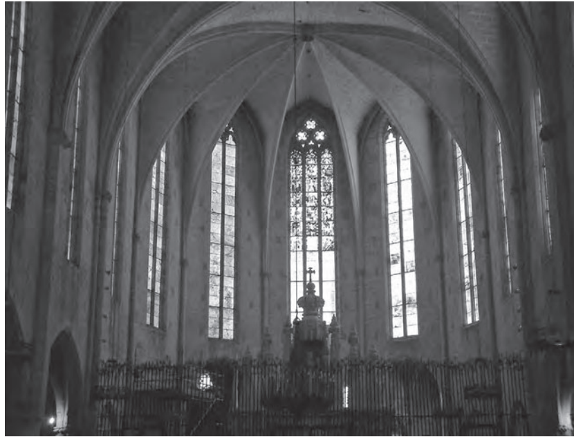
Fig. 4. Imatge actual dels finestrals de l'absis on s'observa la col·locació de plaques d'alabastre arran de la darrera restauració.
