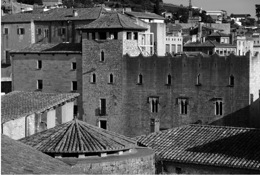
Imatge actual de la Pia Almoina de Girona. Segles XIV-XVI i XX. No hi ha unitat morfològica dels paraments en cap de les façanes; a la principal, dos cossos diferenciats i migpartits per una mena de torre estranya trenquen la uniformitat del conjunt, característica que és constant en cadascuna de les tres façanes (Foto: Gustau Torres Mendoza).
