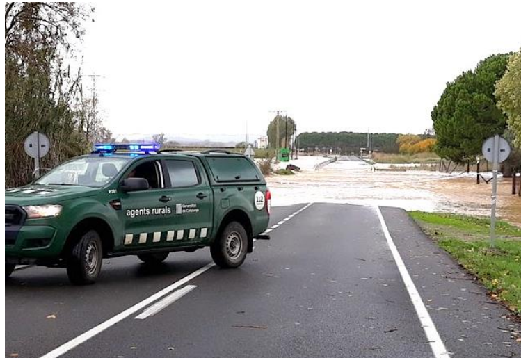
Imagen de la carretera entre Torroella de Montgrí y Parlavà del año 2019. Imagen extraída de protección civil, publicada en el web, naciodigital.cat
