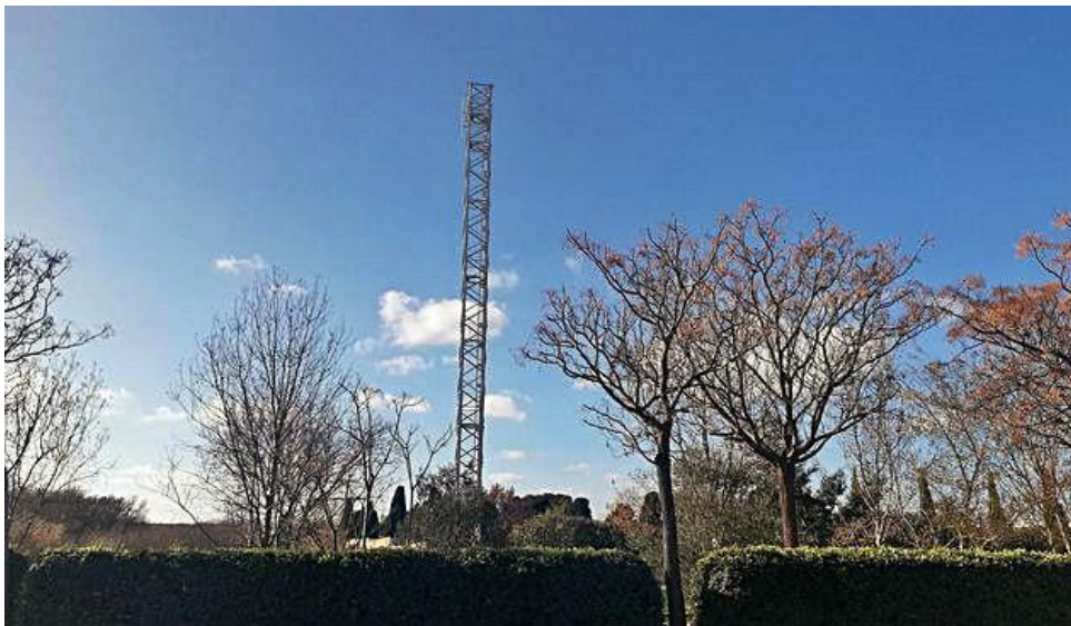
Imagen de la estructura de la torre de telefonía instalada en el cementerio de Figueres (Girona). Imagen extraída del web emporda.info
