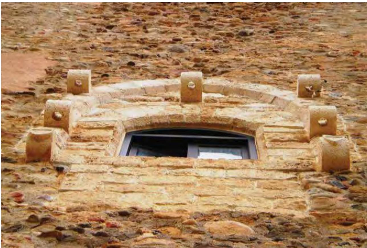
Fig. VII, 87, id., prospetto meridionale, finestra con mensole di sostegno per la chiusura (2013).
