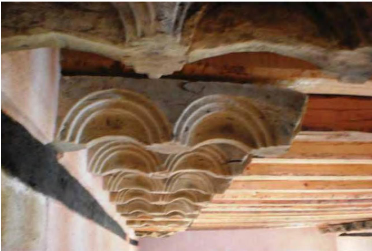
Fig. VII, 86: id, mensole di sostegno del soffitto (2013).
