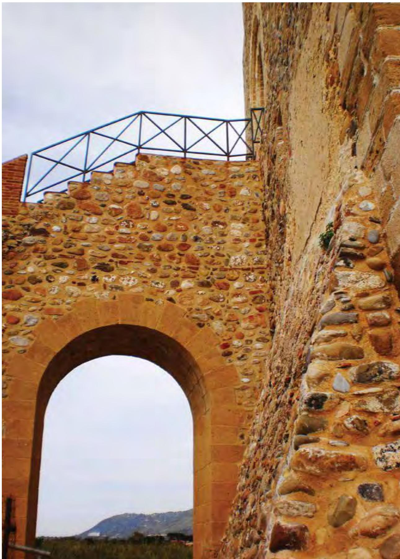
Fig. VII, 85: scala d'accesso al piano nobile con arco ricostruito (2013).
