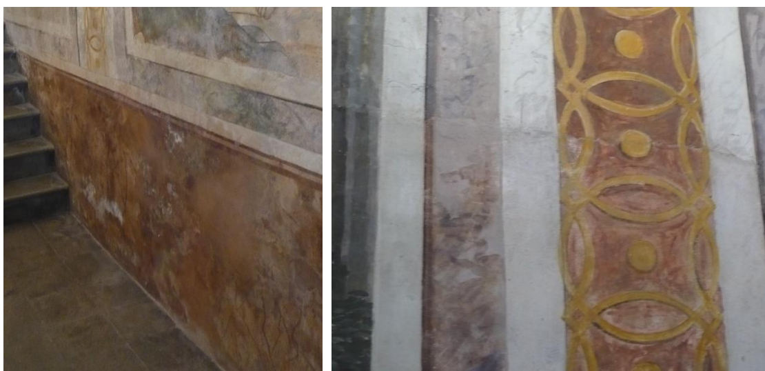
Fig. 21. Fotografies de detall per apreciar les mancances de la restauració: salangre, regalims i llacunes mal resoltes.
