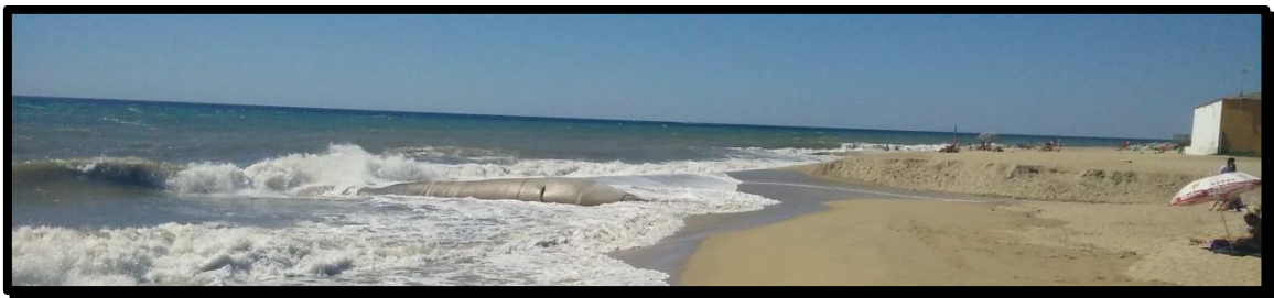
Fotografía 2 Tubo de geotéxtil en la playa. Verano 2015. Autor: HL.
