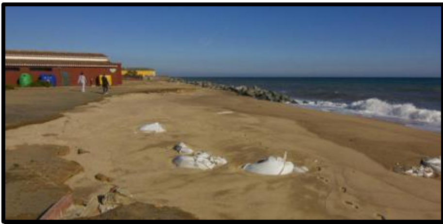
Fotografía 3 Estado de la playa después del fracaso del geotéxtil. Fuente: La Vanguardia.
