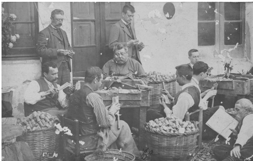
AMLLA. Fons l'Abans. Autor desconegut. Anys aproximats 1849-1900 Retrat d'uns tapers al pati de la fàbrica de Francesc Coris. Partint del carrac el taper amb el ganivet de taper arrodonia la peça. Començava per la banda de millor qualitat, on hi introduïa el ganivet i anava tallant fins deixar el tap amb la característica forma cilíndrica.
