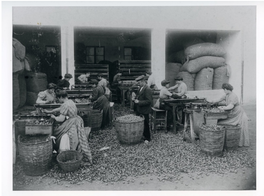
AMLLA. Col·lecció Ajuntament de Llagostera. Autor: Antoni Garcia Asensio. Anys aproximats 1904-1910. Retrat de les treballadores de la fàbrica de Can Coris fent taps amb màquines de garlopa.
