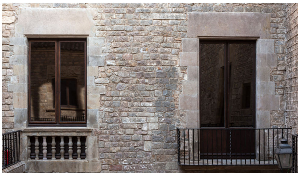
Figura 24. Balcons ampitats (esquerra) i amb volada (dreta) de la façana interior del pati de la finca número 12 del carrer Montcada de Barcelona. Antic casal del marquès de Llió. Actualment, Museu Etnològic i de Cultures del Món. Llindes i muntants de clara adscripció barroca. Notem la solidaritat dels brancals de les obertures amb el mur mitjançant la tècnica de cadena i el relleu de l'angle interior de les peces, treballat amb forma de bocell. Font: Reinald González (Veclus).
