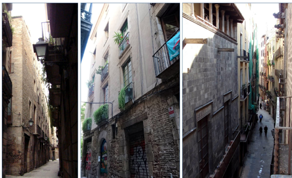
Figura 18. Diferents vistes generals del centre històric de la ciutat de Barcelona: carrer Lledó, carrer de l'Hostal del Sol i carrer Montcada. Notem la presència sistemàtica dels balcons barrocs en volada, sovint al pis principal —planta primera—, però també l'ús del balcó ampitat o ampitador a la resta de l'alçat de les façanes. Aquests tipus de frontis ens donen també referències sobre la fesomia i el volum construït de les cases del conjunt arqueològic del Born. Font: Reinald González (Veclus).
