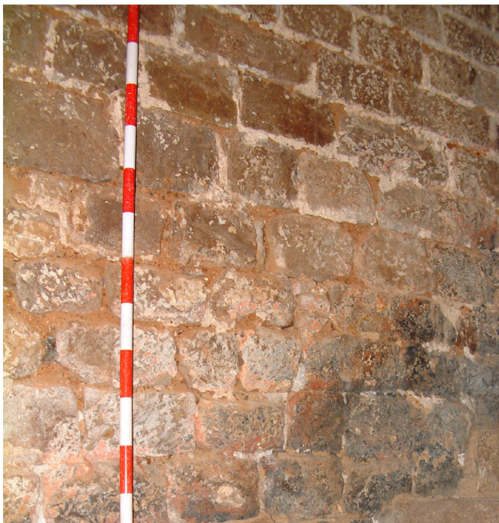
Figura 6. Detall d'un parament del segle XIII on es poden identificar les tapes de juntes o encintats medievals. Tanmateix, la imatge permet distingir el tipus de morter argilós de calç freqüent en l'edificació domèstica barcelonina. Planta pis de la finca número 4 de la plaça de l'Oli. Font: Reinald González (Veclus).
