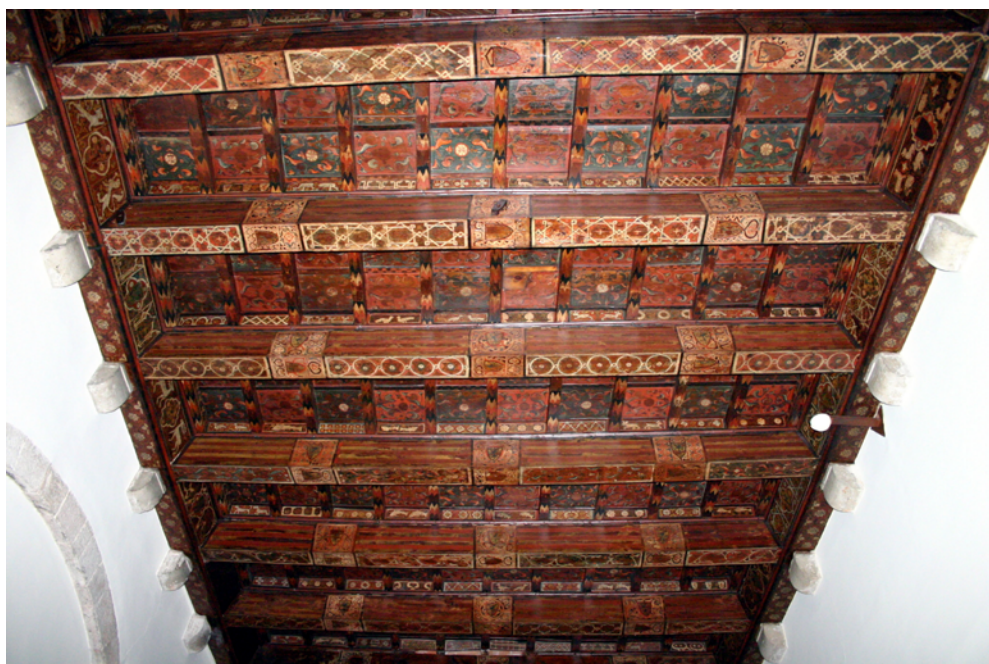
Figura 12. Vista parcial del forjat decorat del segle xv localitzat a la planta primera de la finca número 12 del carrer Montcada de Barcelona. Antic casal del marquès de Llió, actualment Museu Etnològic i de Cultures del Món. Font: Reinald González (Veclus).
