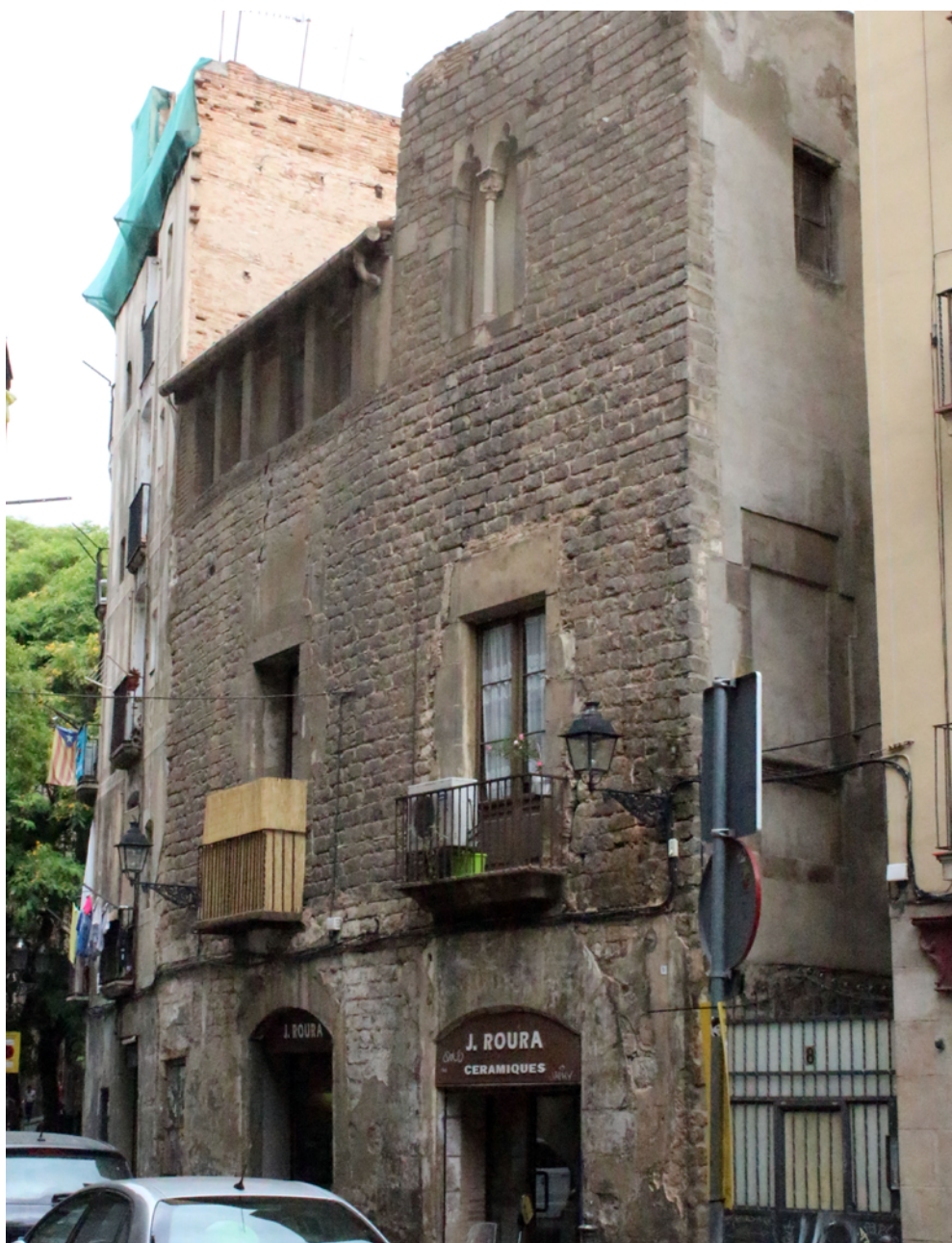
Figura 1. Edifici del segle XIV on podem distingir la porta de la planta baixa del segle XVI —a la dreta—, els dos models de balcons del segle XVII i XVIII, una galeria barroca sota coberta que substituï la porxada gòtica, i un cos lateral amb forma de torre amb una finestra bifora medieval. Front de la finca del número 4 del carrer de les Basses de Sant Pere, centre històric de Barcelona. Font: Reinald González (Veclus).
