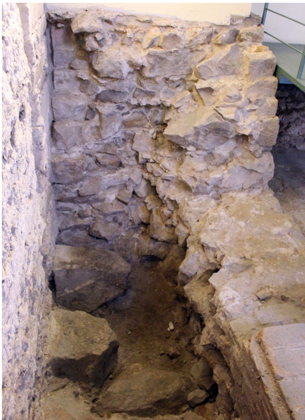
Figura 4. Secció completa de la muralla fundacional de Barcino de finals del segle i aC. Visible avui a l'interior de l'Arxiu Històric de la Ciutat de Barcelona (AHCB), ca l'Ardiaca. Font: Reinald González (Veclus).
