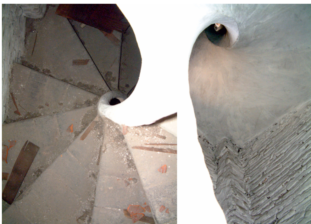
Figura 23. Dues vistes en picat i contrapicat de l'escala helicoidal barroca de la finca número 1 de la plaça de les Beates de Barcelona. Font: Reinald González (Veclus).
