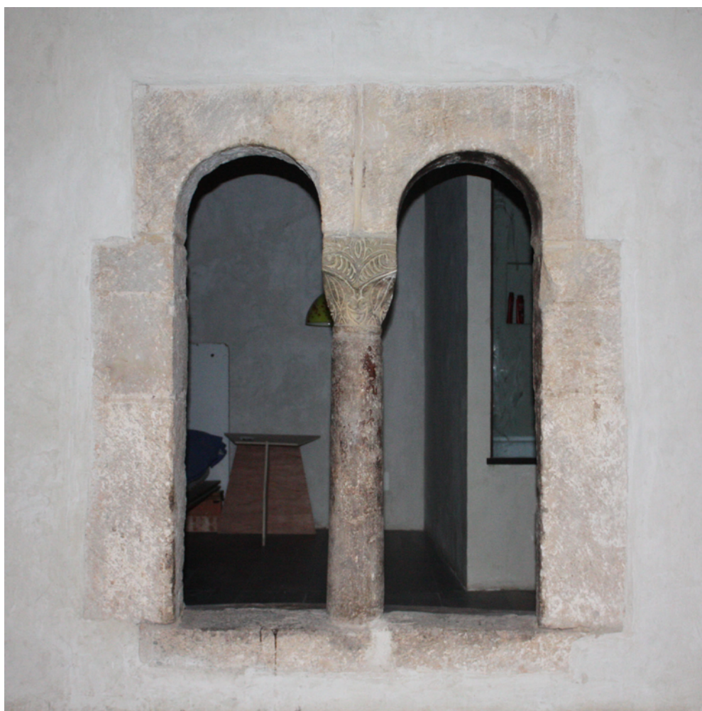
Figura 9. Finestra geminada o de mainell amb llindes monolítiques de mig punt de pedra de Montjuïc (bífora). Disposa d'unes cronologies genèricament tardoromàniques, per bé que és un model ben documentat a la ciutat durant el segle XIII. En aquest tipus d'obertures, el mainell sempre és de secció circular i, com els seus capitells, està fet de pedra de Montjuïc. Finestra localitzada a la finca número 4 de la plaça de l'Oli de Barcelona. Font: Reinald González (Veclus).
