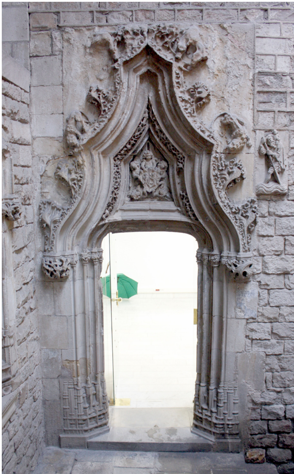
Figura 13. Porta d'accés a l'estudi de l'entresolat de la finca número 15 del carrer Montcada de Barcelona. Antic casal Aguilar. Actualment, museu Picasso. Original del segle XVI, la porta fou restaurada a mitjan segle XX tot destapiant-la, i refent de nou la part inferior dels muntants. És de destacar el treball escultòric amb els impressionants relleus del guardapols mixtilini i la presència d'un sant Cristòfol protector. Tot el conjunt està fet amb pedra de Montjuïc. Font: Reinald González (Veclus).
