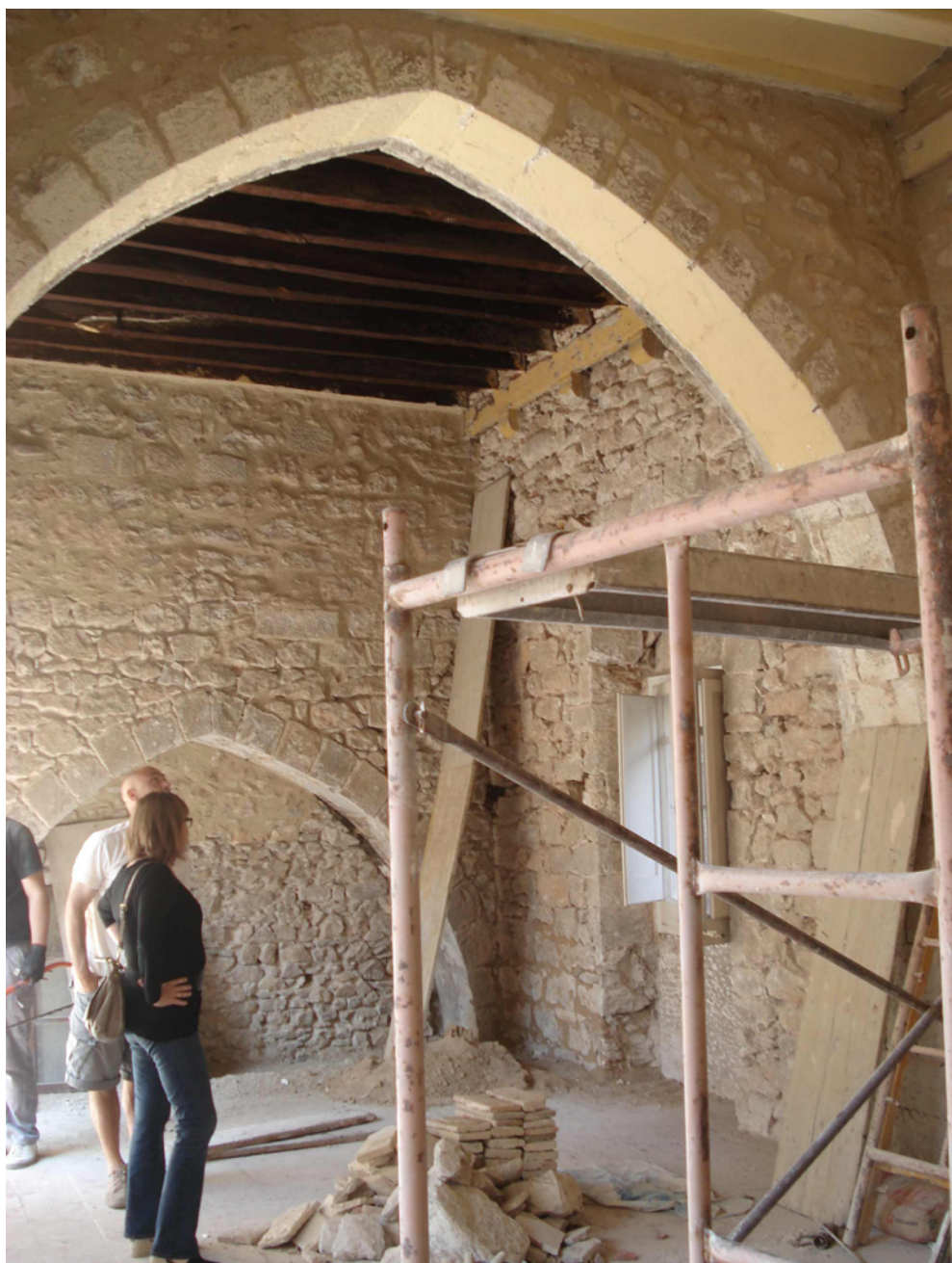
Figura 15. Aspecte interior de la sala de la casa del carrer Alemany, 10 durant unes obres de rehabilitació.
