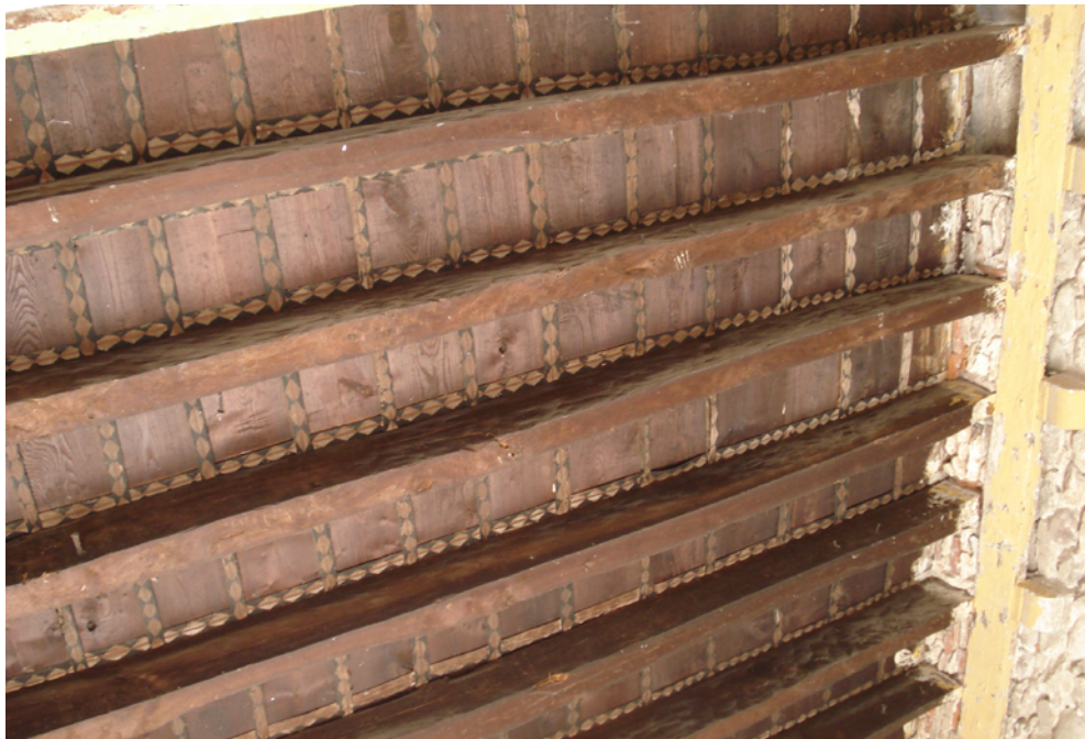
Figura 16. Detall de l'embigat original del sostre de la sala de la casa del carrer Alemanys, 10.
