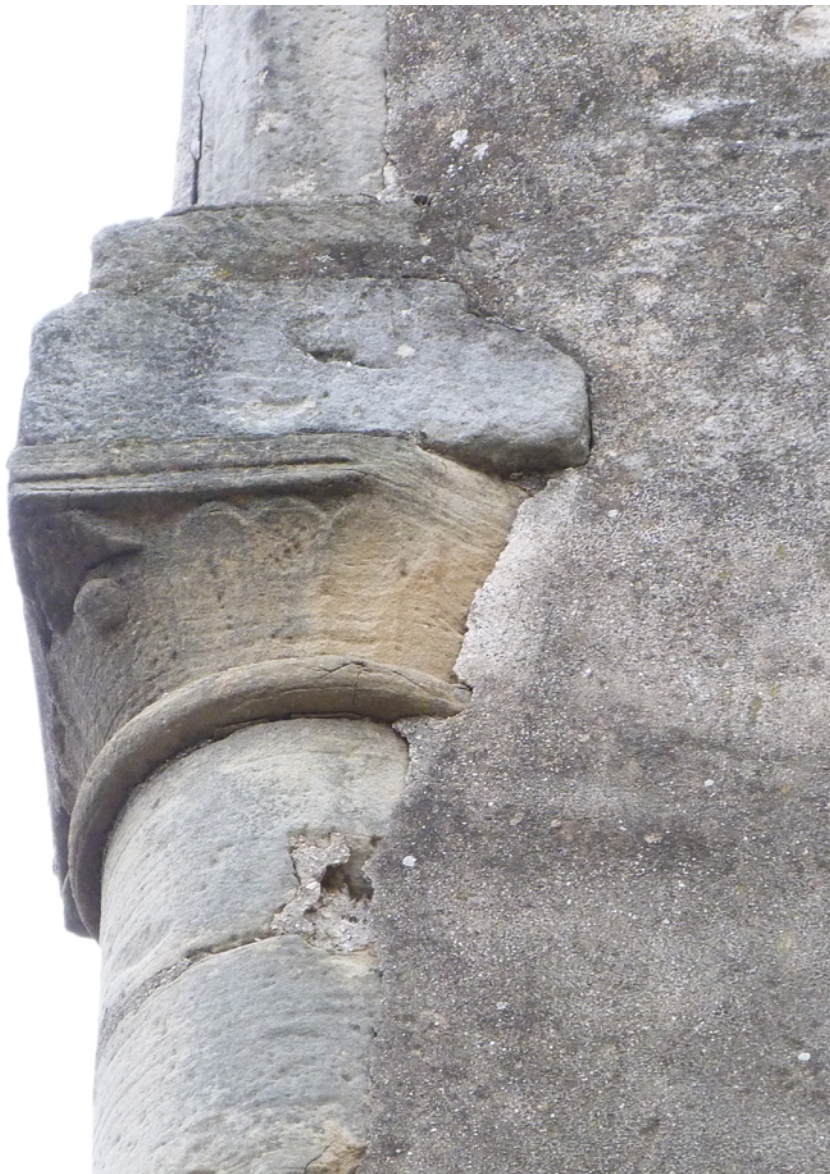
Figure 5. Lodève (Hérault), Grand'rue ; détail des deux piles superposées, l'une circulaire avec chapiteau à décor simple, l'autre polygonale, qui articulaient l'angle des niveaux en pan de bois. Cl. G. Bellan
