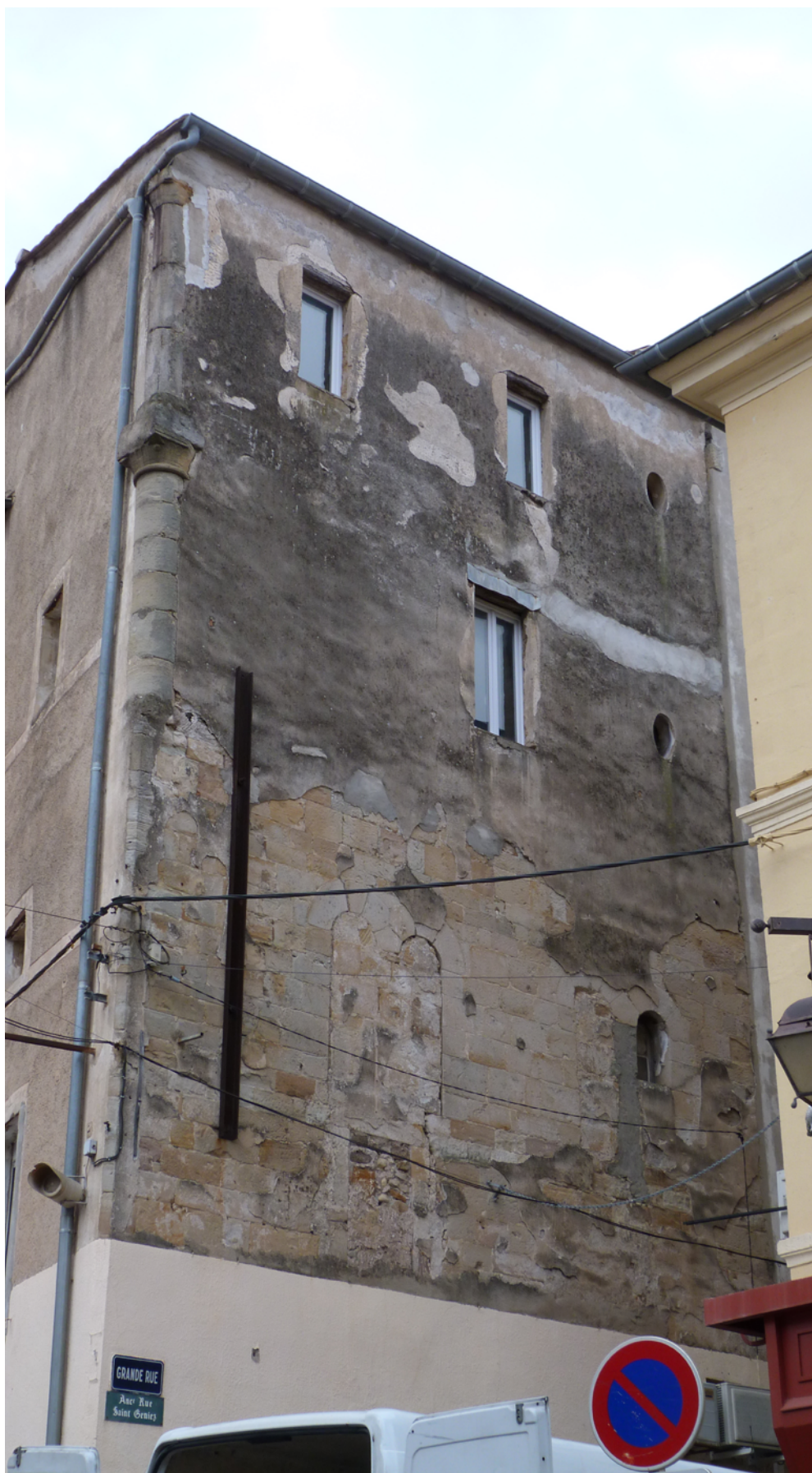
Figure 3. Lodève (Hérault), Grand'rue Premier étage, maçonnerie de pierre de taille. Deuxième et troisième étages : le pan de bois originellement en encorbellement a été remplacé par du moellonnage enduit, d'aplomb avec les niveaux bas. Cl. G. Bellan
