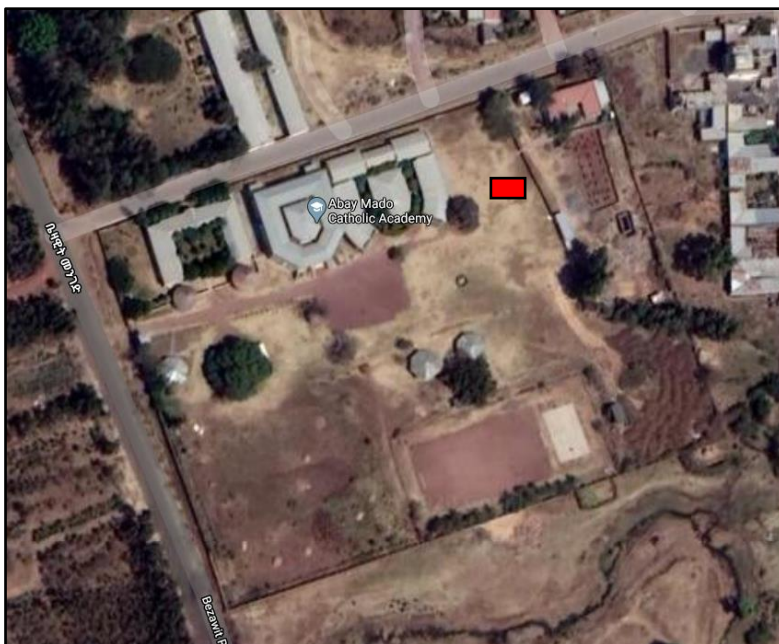
Figura 2. Imatge aèria de l'escola. Ubicació dels panells marcada en vermell.
