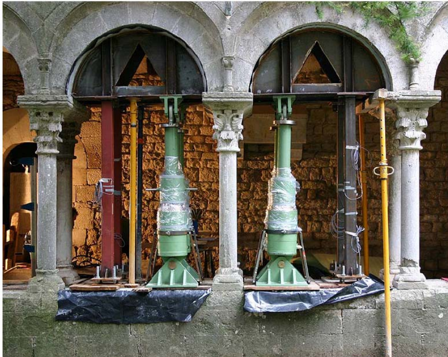
Fig.6. Vista general del muntatge.
