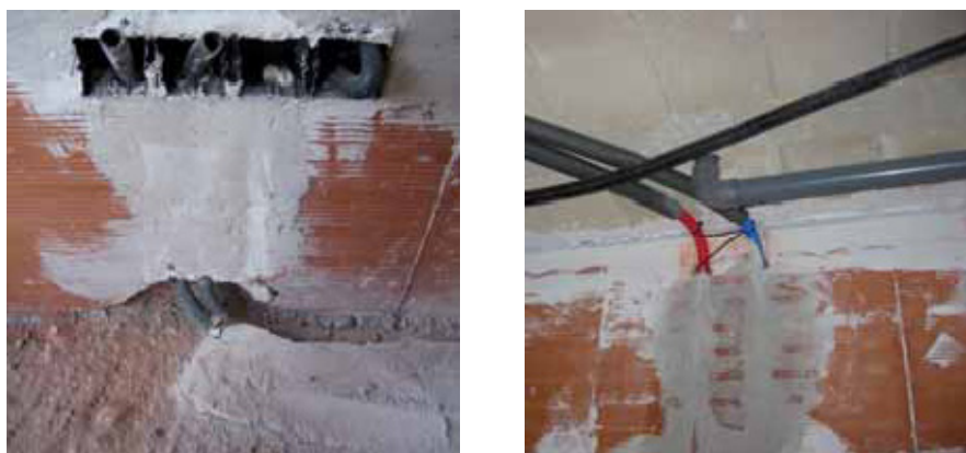
Imatge 17: Exemples de segellament de regates. Imatges extretes del manual pel Disseny i execució de parets Silensis, editat per Hispalyt.
