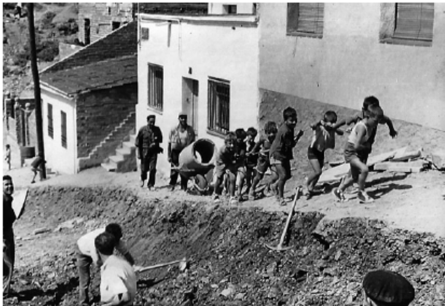
Instal·lant el clavegueram els diumenges al barri de Roquetes. Any: 1964.
