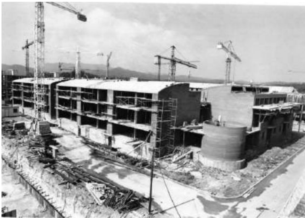
Fotografia 4. Imatge de la Vila Olímpica en construcció (s.d.). Imatge extreta del treball de recerca de Pol Pagès. Font original: Pere Duran.
