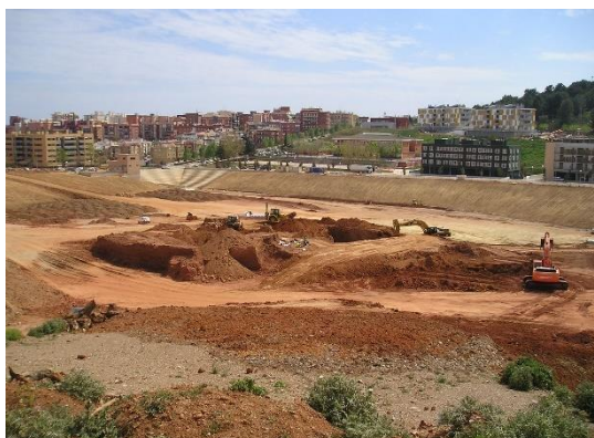
Imatge 7. Obres a la Riera de Sant Llorenç, amb l'excavació paleontològica.
