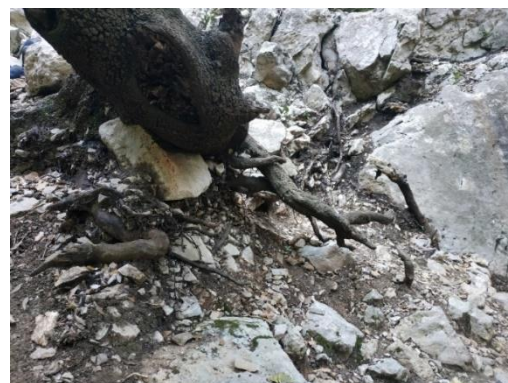
Imatge 46 Alzina afectada per l'erosió del peu de via al sector Iniciació
