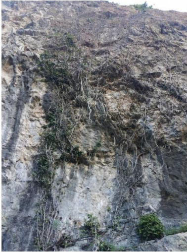
Imatge 91 Espai entre via i via on permet a la flora colonitzar la paret tot i que és veu en un estat força sec
