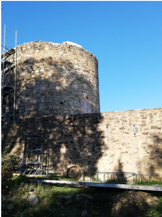
Foto 1 (esquerra): Torre Montagut. Aquí podem veure part de la muralla restaurada, amb les espitlleres i el parapet del terrat. També i veiem el rellotge solar. Fotografia presa el dia 11/3/2020.
