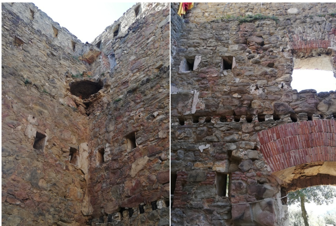
Foto 3 (esquerra): Restes de la garita de la torre Canadell. Fotografia presa el dia 11/3/2020.
