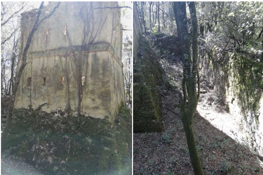
Foto 2 (esquerra): Exterior de la torre. Veiem les diferents espitlleres, la línia divisòria de les plantes i la base atalussada. Fotografia presa el dia 11/3/2020.
