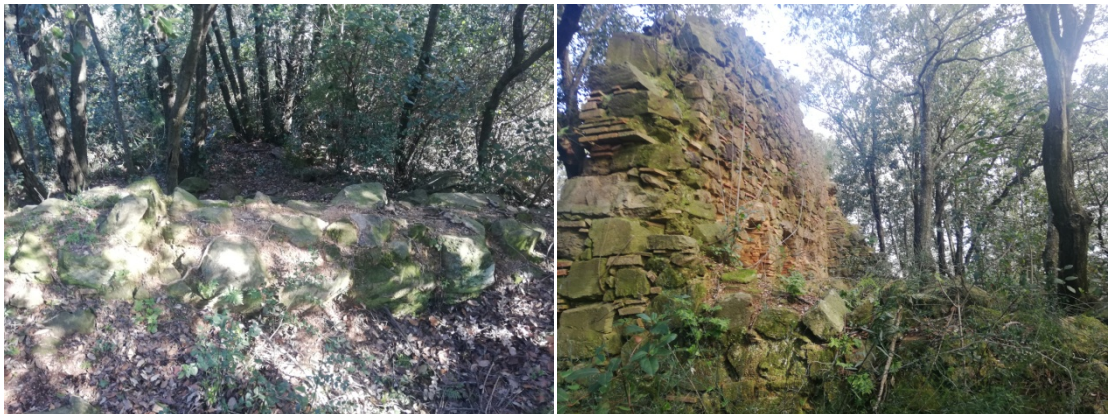
Foto 3 (esquerra): Part de la base de la torre, encara visible i que es conserva en un estat prou bo. Fotografia presa el dia 1/2/2020.
