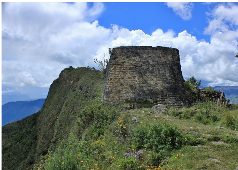
Imagen nº11. Vista lateral del Torreón de Kuélap. Extraída de: Museoleymebamba.org.
