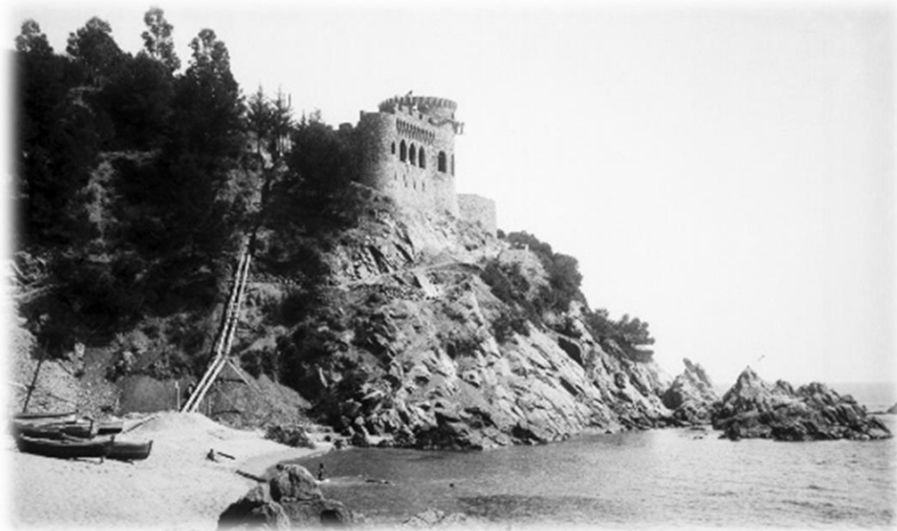
Il·lustració 47 Obres de construcció del Castell d'en Plaja. 1939 ca. Procedència: SAMLM -Fons Josep Maria Coll i Parés. Autor: Josep Maria Coll i Parés.
