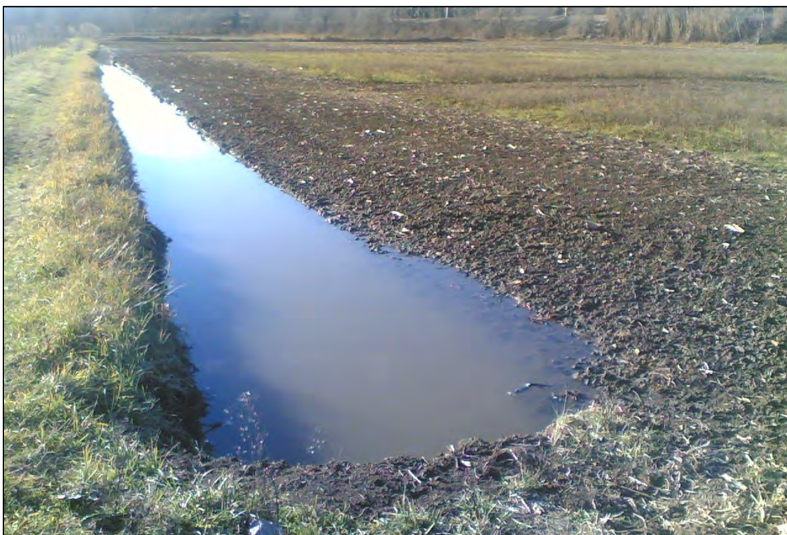
Figura 306. Canal de desguàs acabat de netejar per tal de garantir el correcte moviment de l'aigua. Prats de l'antic estany de Sils (Selva), 6-I-2008.
