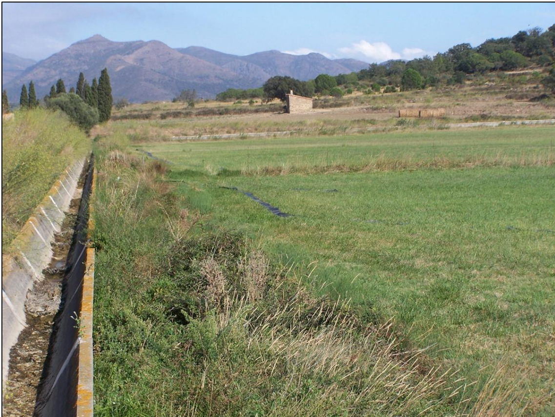
Sistemes de reg (canals de ciment i mangueres de plàstic) del prat del Timonar [PAL-461], Palau-saverdera (19-VIII-2008).
