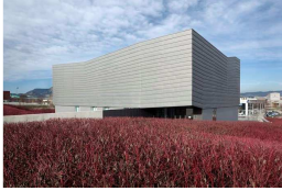
Imatge 36 Exterior de l'Arxiu Comarcal d'Osona.
