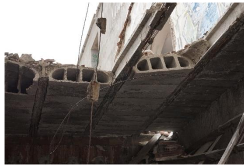
Figura 11. Detall d'un forjat de planta baixa.
