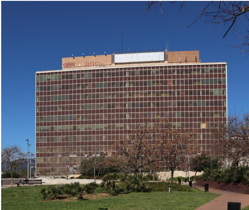
Il·lustració 1: Fotografia de l'edifici Gesa. Font: Creació pròpia.
