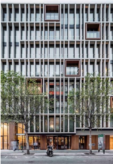
Il·lustració 11: Fotografia de la façana de l'antic edifici d'oficines convertit en hotel a Barcelona.
