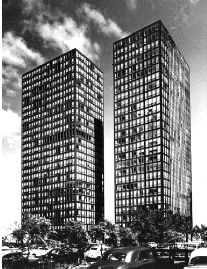
Il·lustració 17: Imatge dels Lake Shore Drive Apartments, primeres obres del Moviment Internacional a Chicago.
